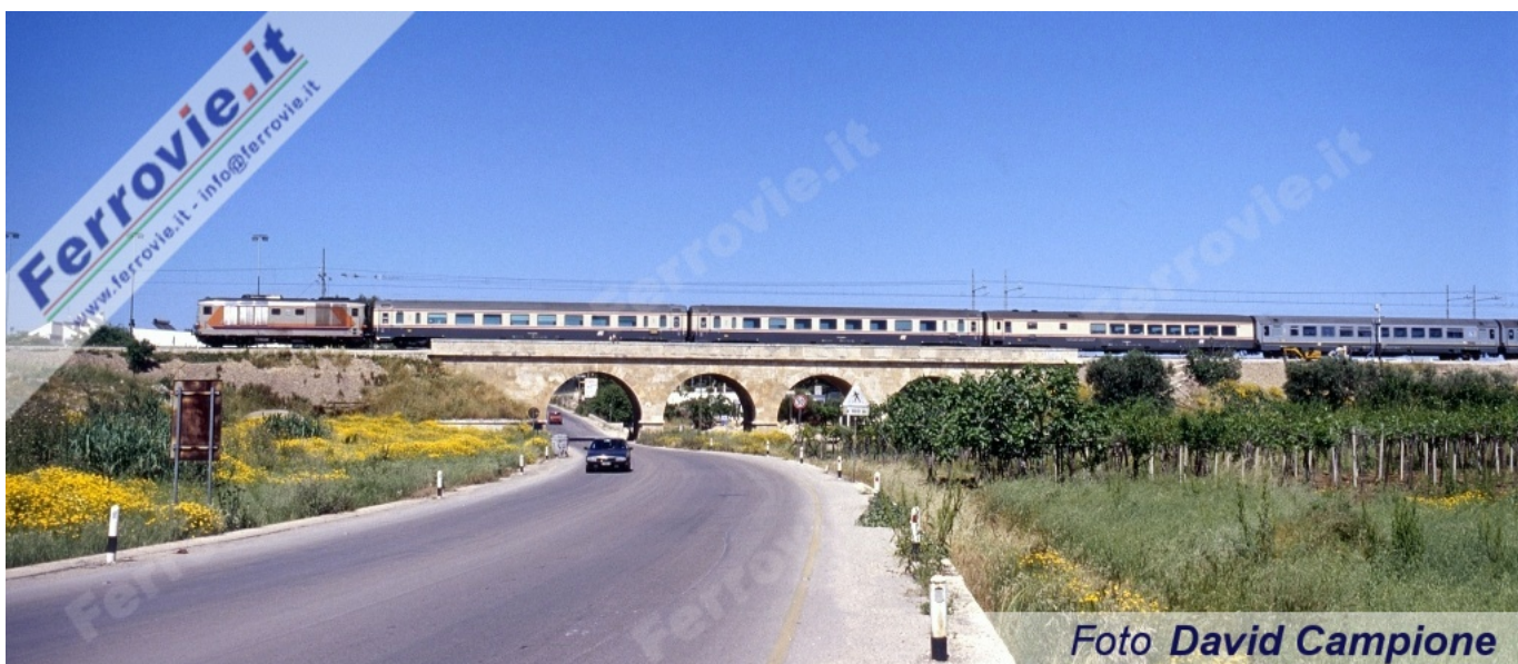
9. Fino all'attivazione della trazione elettrica, avvenuta con lo scorso orario estivo, sulla linea Bari-Lecce circolavano gli Intercity provenienti e diretti a Milano che erano gli unici ad essere regolarmente composti da vetture GC e trainati da locomotori diesel; nella foto l'IC 580 "Adriatico" Lecce-Milano C.le con in testa una D.445 nei colori navetta (Foto David Campione, 21 maggio 1996)
