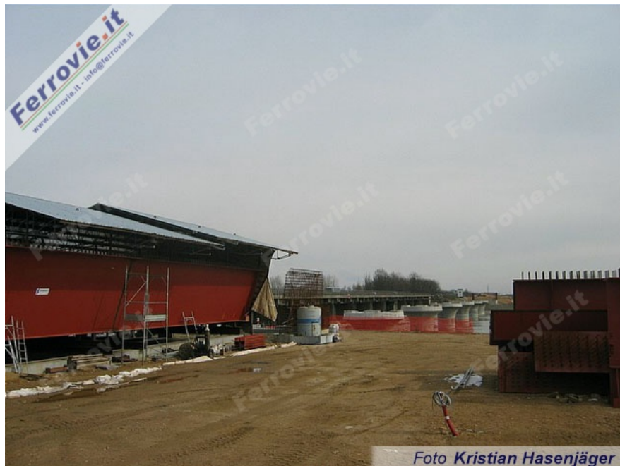
4. Il ponte metallico viene montato per terra, per poi essere traslato sui piloni nel fiume. (Foto Kristian Hasenjäger, 29 febbraio 2004)
