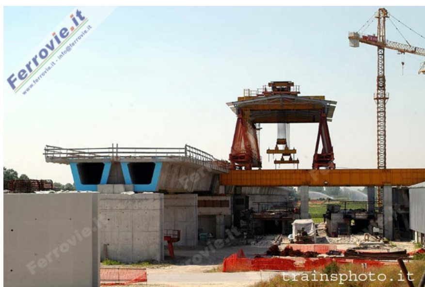
Altra inquadratura del viadotto Piacenza, con l'impalcato in fase di allestimento. (Foto Maurizio Tolini, 9 giugno 2004)
