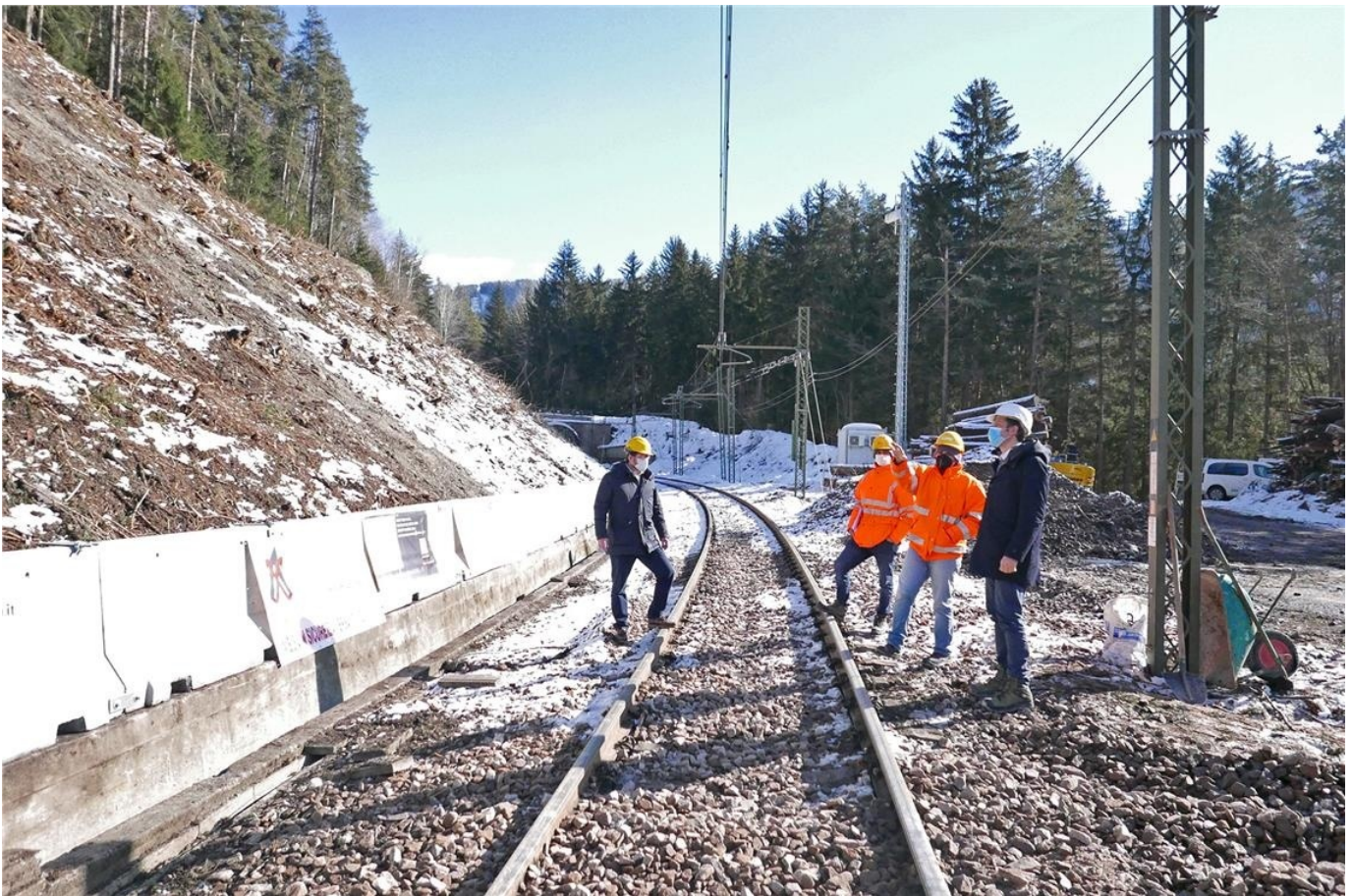
2. L'Assessore Alfreider (a destra), assieme al Presidente di STA Ausserdorfer e ad alcuni tecnici di RFI, si è fatto un quadro dell'andamento dei lavori sulla ferrovia della Pusteria a Valdaora. (Foto ASP/Ingo Dejaco)
