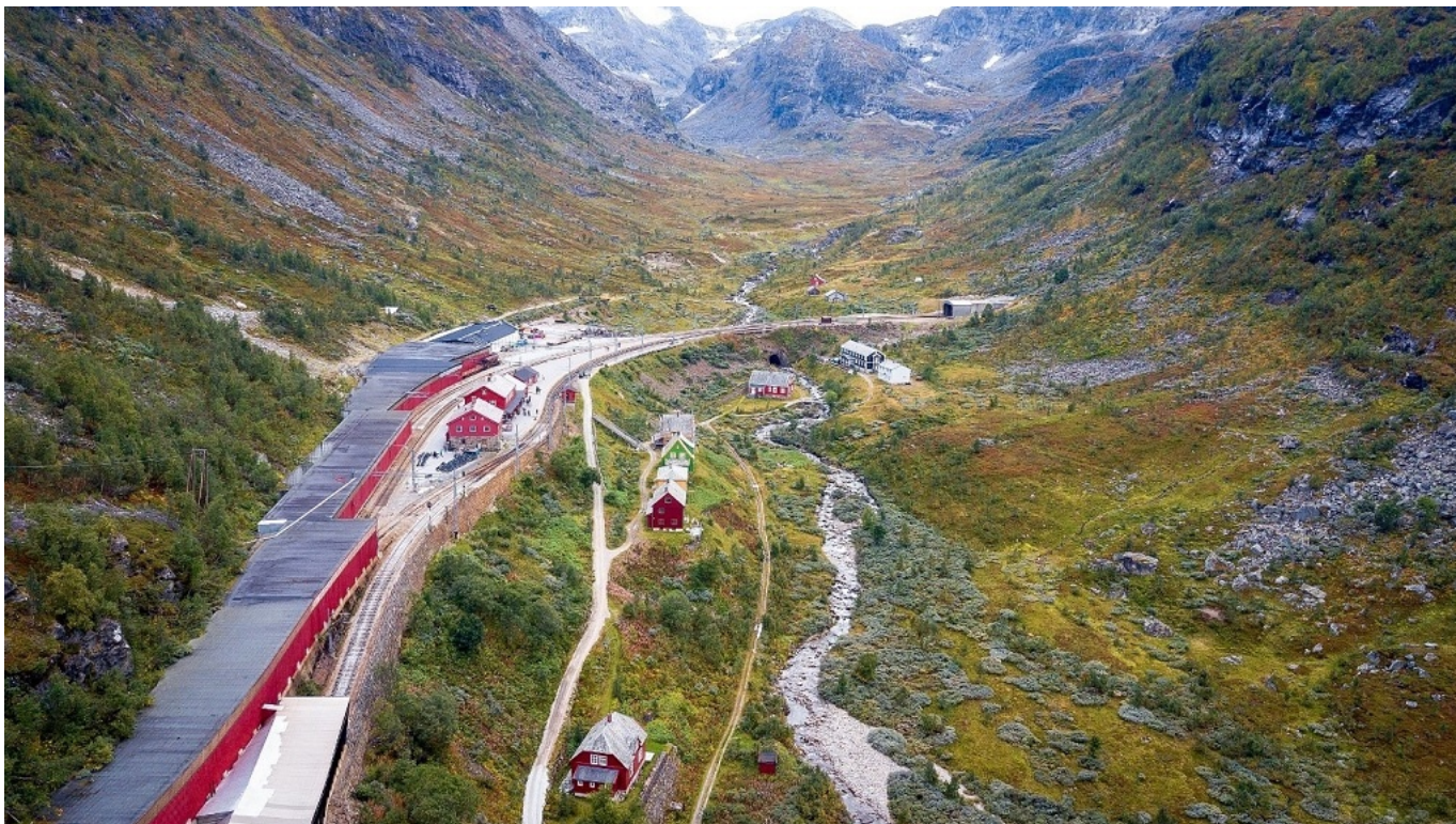
4. La stazione di Myrdal. Sulla destra lo sbocco del tunnel Gravahal (5.311 m) in direzione ovest, il più lungo della linea Oslo - Bergen. Sulla sinistra, in rosso, i tunnel frangineve della linea Oslo - Bergen in direzione Oslo e in bianco il primo tunnel della Flåmsbana. (Foto Tore Sætre, 02 settembre 2018)
