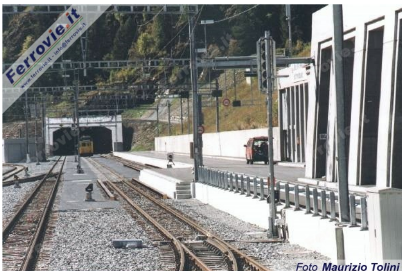
3. Portale engadinese di Sagliains con la piattaforma di carico, riconoscibile per le controrotaie esterne ai binari di corsa. (Foto Maurizio Tolini, 1 ottobre 1999)
