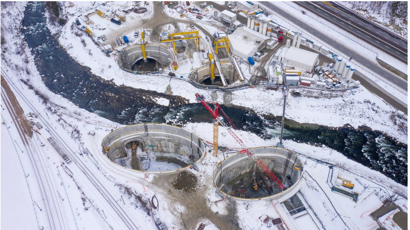
11 I quattro pozzi per scavare in totale 4 gallerie sotto al fiume: 2 tunnel principali e 2 gallerie di interconnessione. Foto BBT
