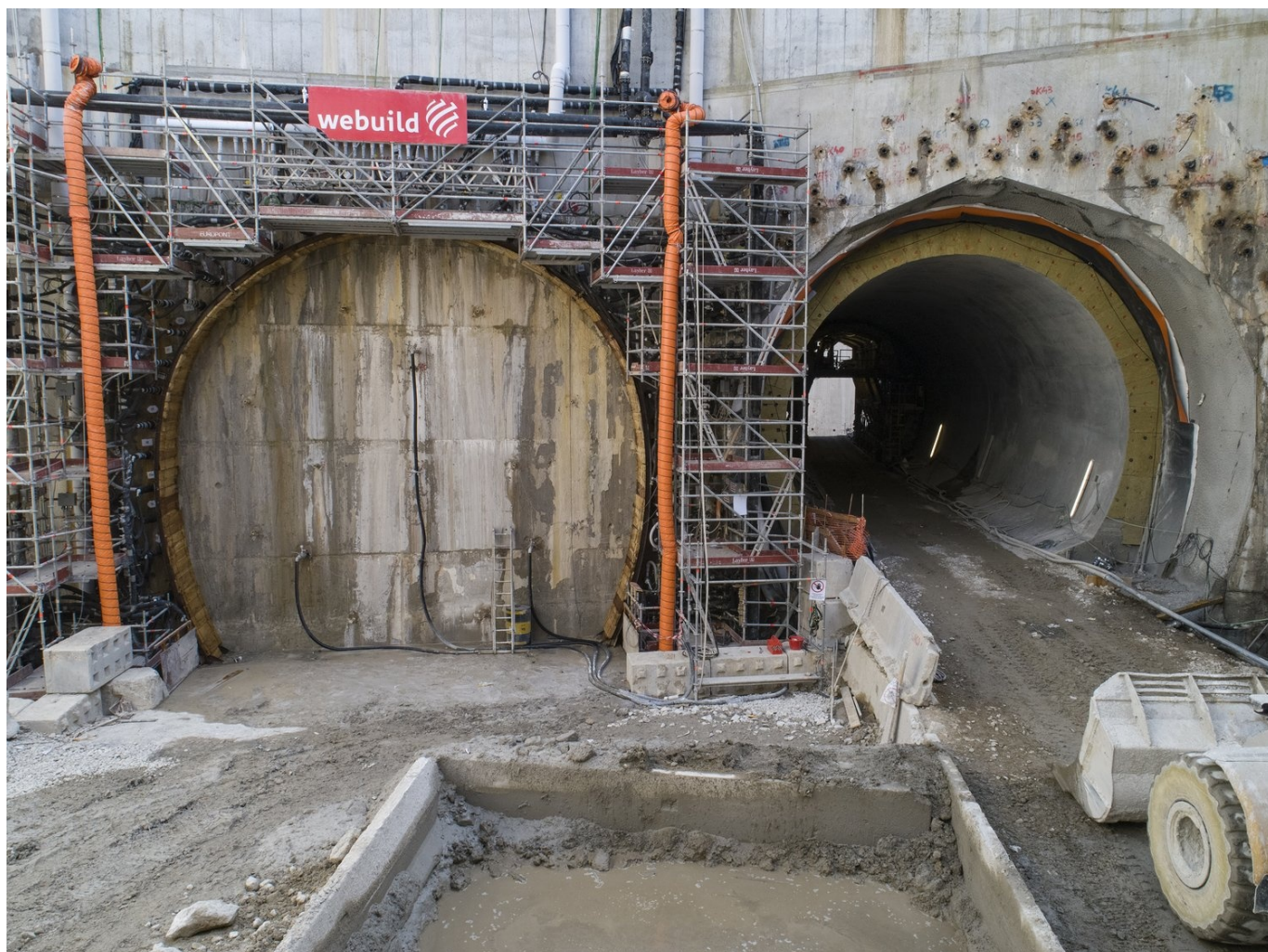
22 Inizio della procedura di congelamento. (Foto BBT)
