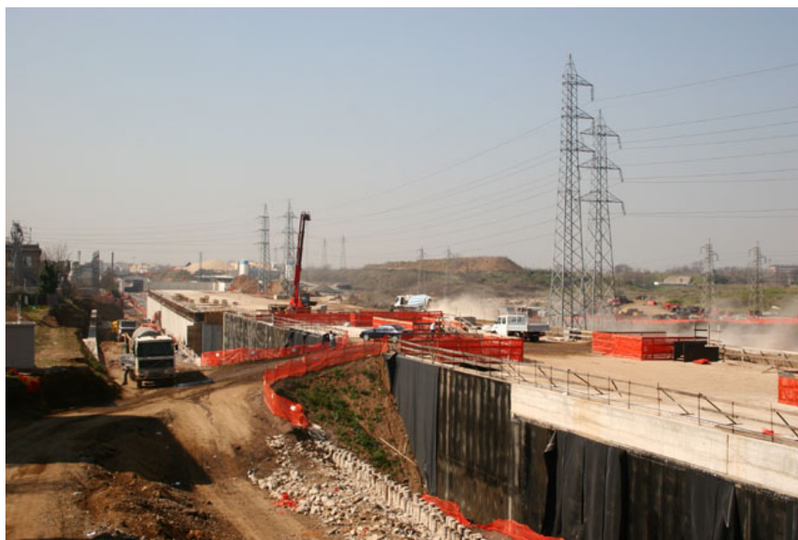
Nei pressi di Viale della Serenissima si sta provvedendo al completamento della galleria artificiale, che ospiterà i binari dell'AV Roma - Napoli. A fianco la galleria della Roma - Sulmona che ospiterà la nuova fermata "Serenissima" all'altezza del viale omonimo. (Foto David Campione, 17 febbraio 2005)
