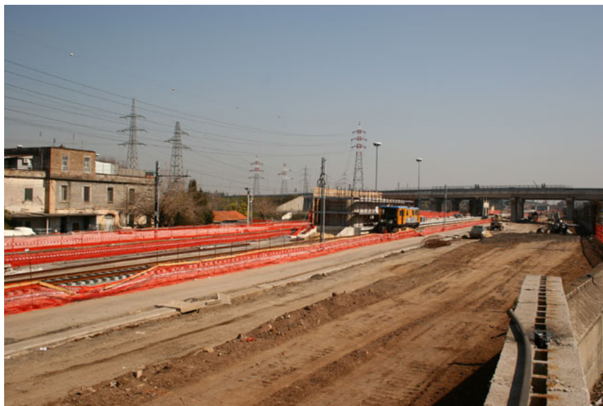
Nei pressi di Palmiro Togliatti le due linee ferroviarie correranno all'aperto. A sinistra il binario unico della linea per Sulmona in nuova sede già in esercizio ed il vicino binario di raddoppio in allestimento. Qui sorgerà la nuova fermata "Palmiro Togliatti", in costruzione tra i due binari. A destra nell'immagine il sedime per l'Alta Velocità. (Foto David Campione, 17 febbraio 2005)
