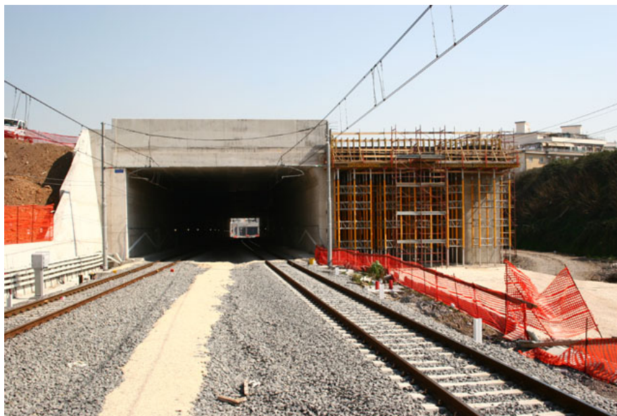
Estremità lato Sulmona della stazione di Roma Prenestina. In questo impianto sono già stati abbandonati i primi binari adiacenti il fabbricato viaggiatori e spostati dove sorgevano i binari di precedenza della stessa stazione. A destra la galleria artificiale in completamento per la linea AV. (Foto David Campione, 17 febbraio 2005)
