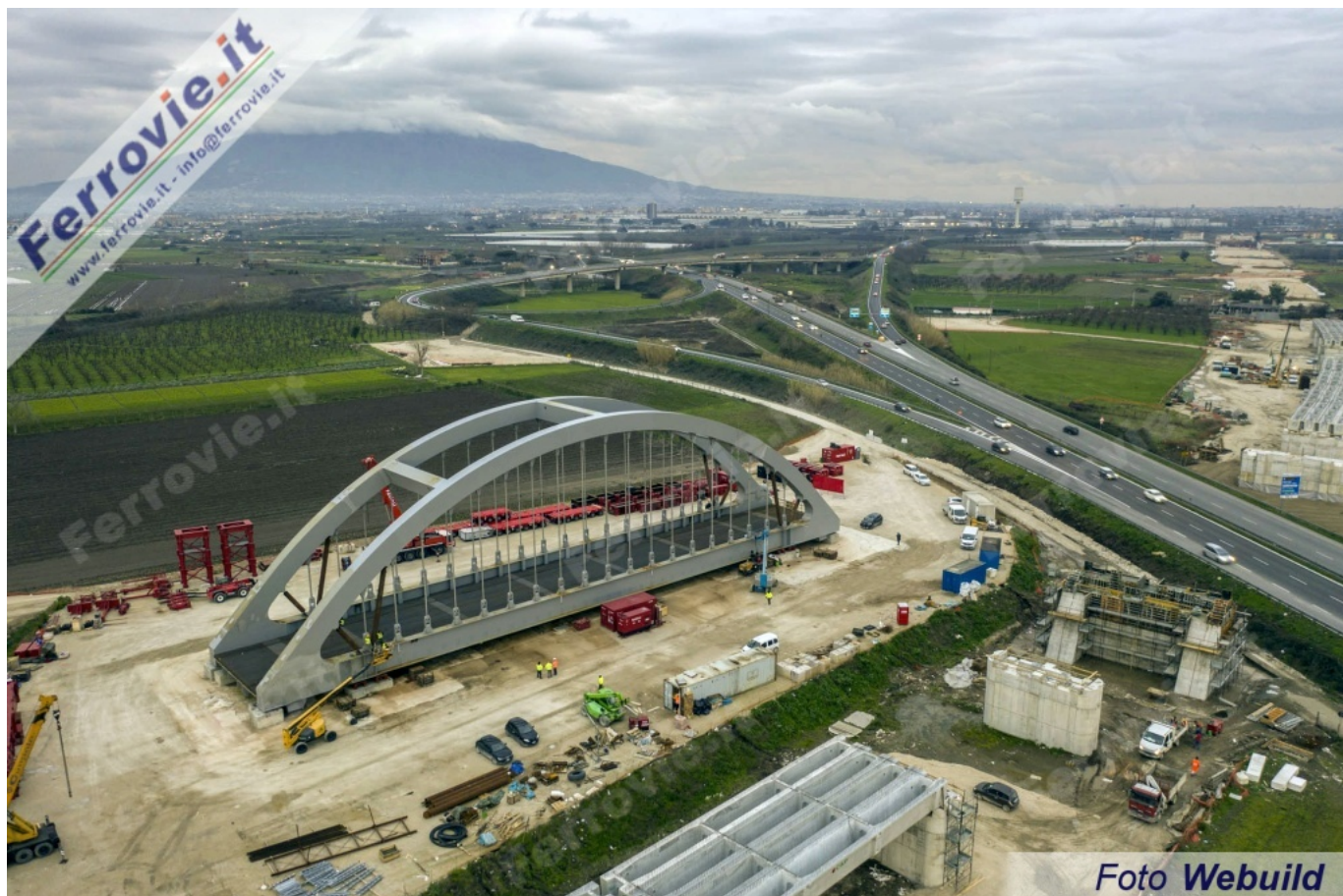
Ponte in acciaio per la linea Napoli - Canello, pronto per il varo sull'Asse Mediano. (Foto Webuild)
