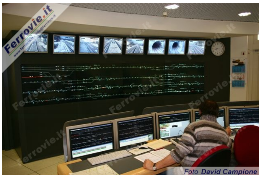
8. Sala del DCO della Merano - Malles, ospitata nel fabbricato viaggiatori RFI di Merano, in 1° binario. (Foto David Campione, 28 gennaio 2005)
