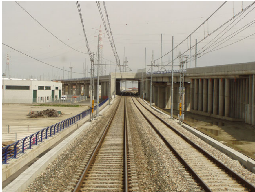
4. Il nuovo manufatto che ospita la linea Alta Velocità per Milano nel punto in cui scavalca la Torino - Milano. Foto Trainsphoto.it , 10 aprile 2005
