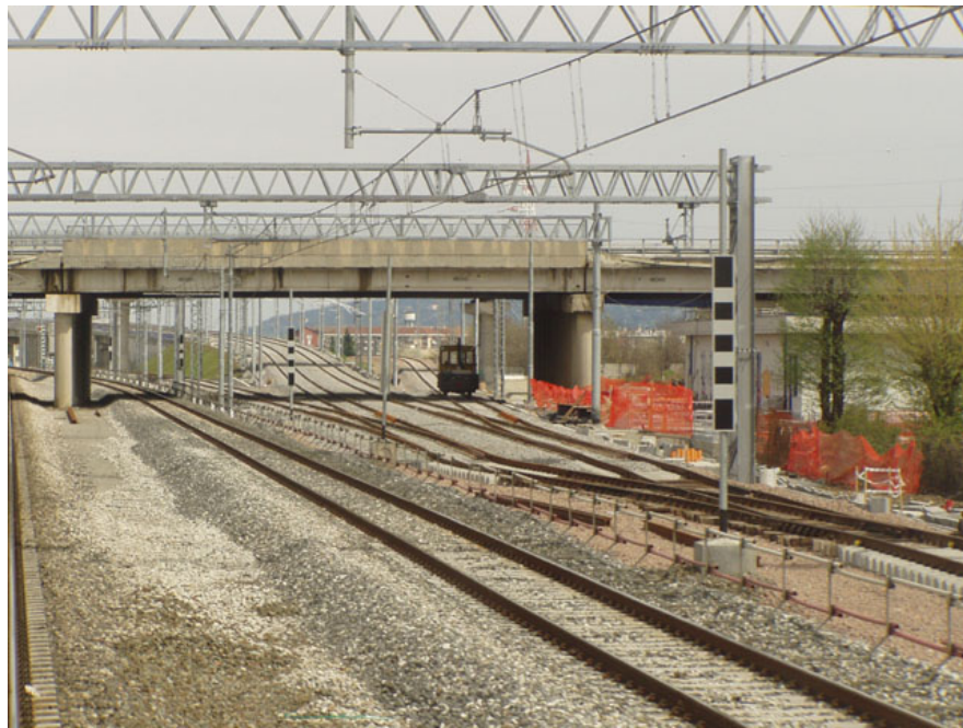
3. Il cantiere con l'interconnessione di Torino Stura, dove ha inizio l'Alta Velocità per Novara - Milano. Sulla destra è evidente il tracciato del doppio binario, che affronta una rampa per scavalcare la linea storica. (Foto Trainsphoto , 10 aprile 2005)
