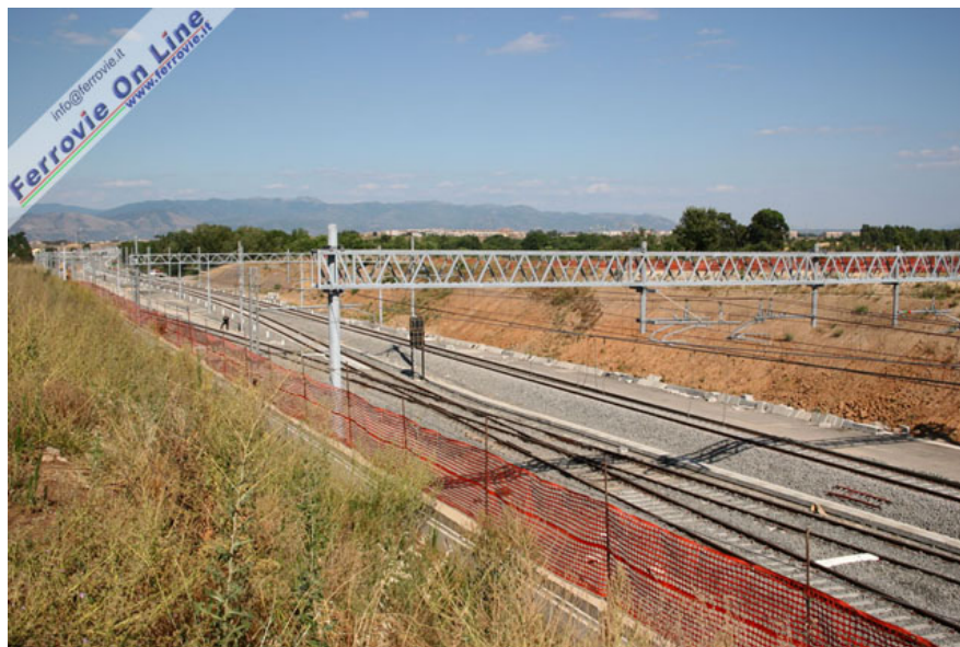
Tra La Rustica e Salone la linea AV si distacca dalla linea tradizionale. A destra nell'immagine i due binari per Napoli che confluiscono nel tracciato storico. Foto David Campione, 3 luglio 2005
