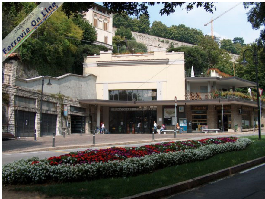
2. Vista esterna della stazione inferiore (Foto Mario De Prisco, 8 settembre 2005)
