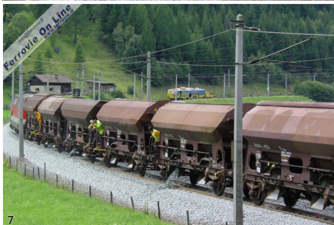
5. Dopo la sostituzione del binario, un treno cantiere è incaricato del rinnovo della massicciata. Il convoglio è in doppia simmetrica con la 2043 076... (Foto Fabio Veronesi, 25 agosto 2005) 6. ...e la 2043 052. (Foto Fabio Veronesi, 25 agosto 2005) 7. Dai carri tramoggia viene scaricato il pietrisco sotto lo sguardo attento degli addetti mentre poco più indietro una rinalzatrice attende di poter iniziare il proprio lavoro. (Foto Fabio Veronesi, 25 agosto 2005) 8. Il carro tramoggia 942 1 015-4 all'opera. (Foto Fabio Veronesi, 25 agosto 2005)
