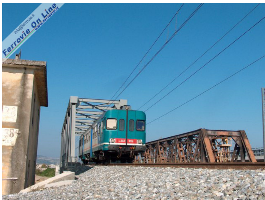
La ALn 668.1026, impegnata nell'effettuazione del Regionale 8519 da Sibari a Cosenza, transita sul nuovo ponte. Foto Mario De Prisco, 29 ottobre 2005
