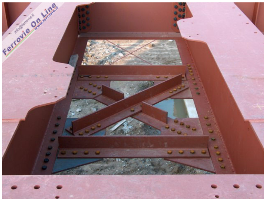
Le crociere inferiori fra i longheroni destinati a sostenere il binario. (Foto Mario De Prisco, 06 febbraio 2005)
