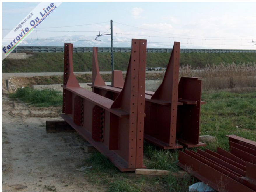
Cominciano ad arrivare in cantiere i componenti del "kit". Qui vediamo le traverse inferiori. (Foto Mario De Prisco, 06 febbraio 2005)
