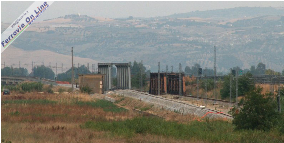
Una panoramica del cantiere mentre sono in corso i lavori di posa del binario. Sullo sfondo si nota il primo viadotto della variante attivata qualche anno fa. Foto Mario De Prisco, 12 agosto 2005
