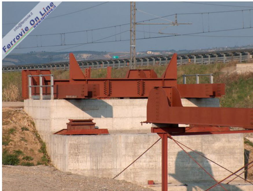
Sulla spalla nord è stata provvisoriamente posizionata la parte terminale dell'impalcato inferiore. Foto Mario De Prisco, 06 febbraio 2005
