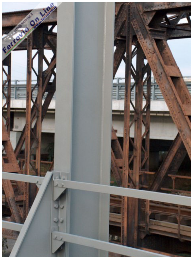
A confronto la lineare eleganza dei profilati adottati per il nuovo ponte e il merletto di chiodature che furono necessarie per l'assemblaggio del vecchio manufatto. (Foto Mario De Prisco, 18 settembre 2005)
