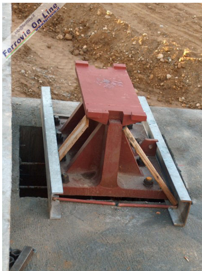
La cerniera sulla spalla sud posizionata ma ancora da cementare. (Foto Mario De Prisco, 28 novembre 2004)
