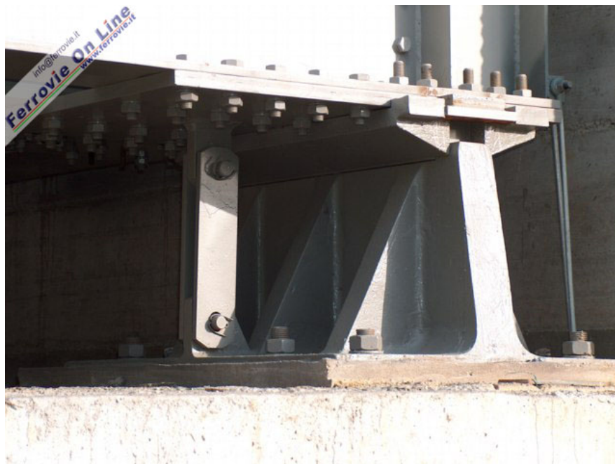
Particolare dell'appoggio. (Foto Mario De Prisco, 18 settembre 2005)
