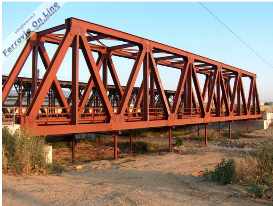
La costruzione è ormai terminata anche se sono ancora presenti i sostegni provvisori e manca la verniciatura definitiva. Foto Mario De Prisco, 27 maggio 2005
