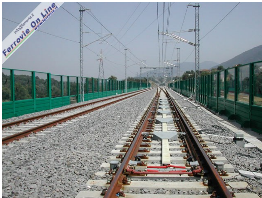
6. Deviatoio tipo S.60 UNI 3000 con tangente 0,022 ed inclinazione 1/20, qui in opera presso il PC Ceccano. Dispone di cuore a punta mobile e consente la velocità massima di 160 km/h sul ramo deviato. (Foto David Campione, 26 giugno 2003)
