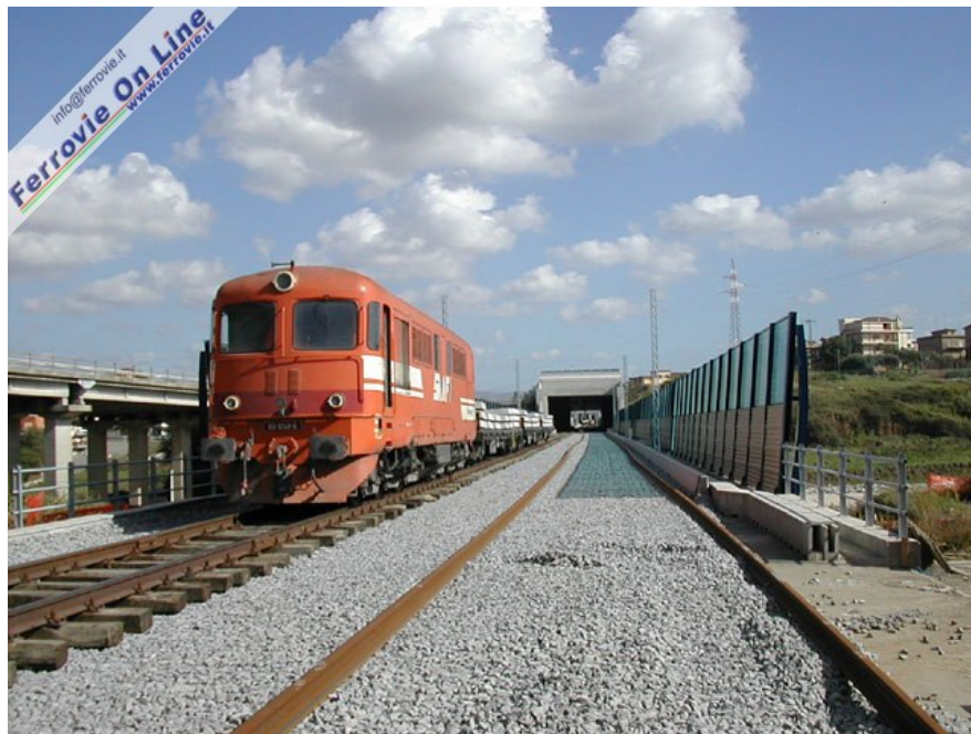
5. Un tratto di linea in fase di allestimento nei pressi di Lunghezza. Alla data della foto dopo la posa del pietrisco era iniziata la posa delle traverse e quindi dell'armamento. (Foto David Campione, 25 ottobre 2004)
