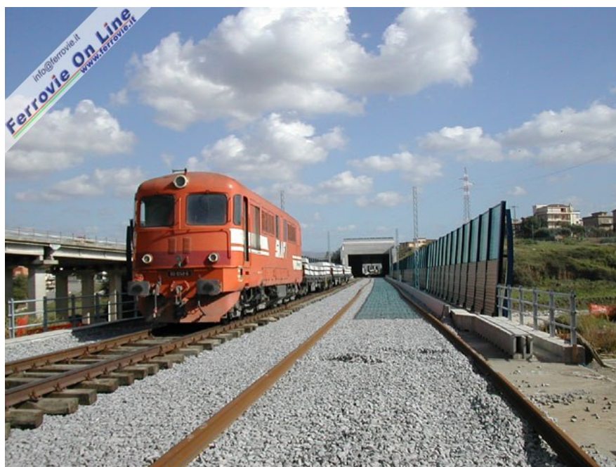
5. Un tratto di linea in fase di allestimento nei pressi di Lunghezza. Alla data della foto dopo la posa del pietrisco era iniziata la posa delle traverse e quindi dell'armamento. (Foto David Campione, 25 ottobre 2002)
