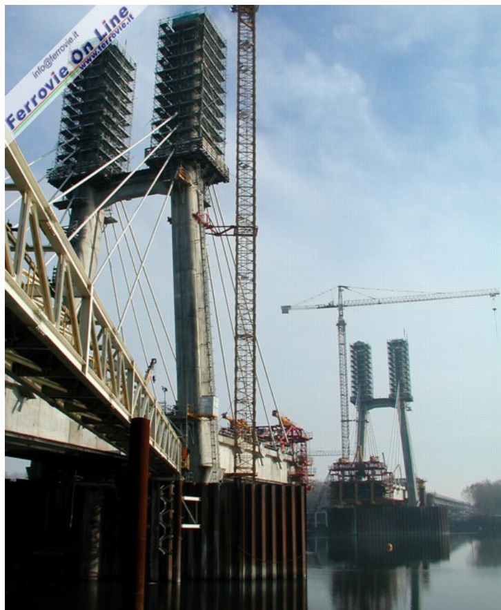
Vista dalla sponda destra dei due piloni del ponte strallato di attraversamento del Po. E' ben evidente l'imponenza del manufatto che sarà amplificata al completamento dell'opera quando le torri raggiungeranno l'altezza di 65 metri. Ciascuna torre è appoggiata su una fondazione profonda comprendente 28 pali di grande diametro. (Foto Pietro de' Castiglioni, novembre 2005)
