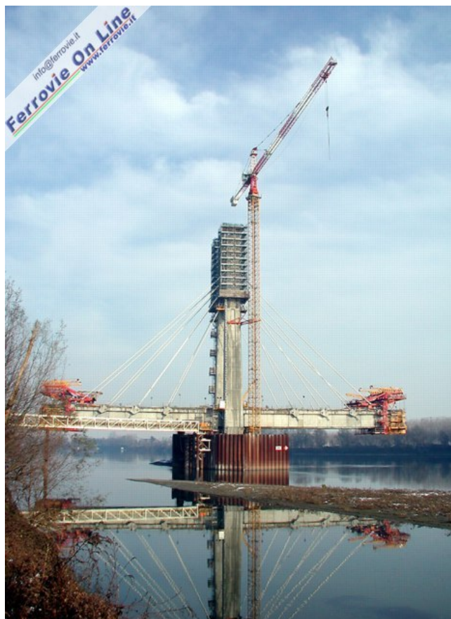
Altra veduta del pilone sud del ponte strallato in costruzione. Il ponte è la parte più importante di un sistema di viadotti esteso per 1343 metri che si rendono necessari per il superamento degli argini nonchè della zona golendale destra. (Foto Pietro de' Castiglioni, novembre 2005)
