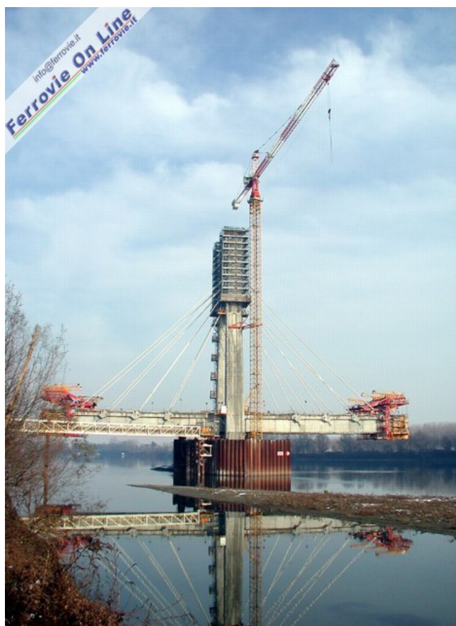
Altra veduta del pilone sud del ponte strallato in costruzione. Il ponte è la parte più importante di un sistema di viadotti esteso per 1343 metri che si rendono necessari per il superamento degli argini nonchè della zona golenale destra. (Foto Pietro de' Castiglioni, novembre 2005)
