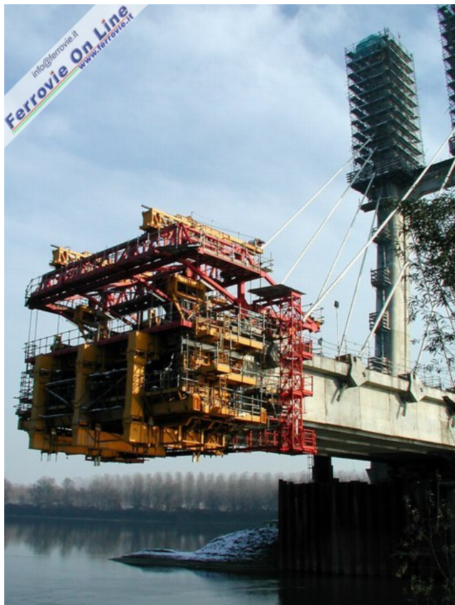
La cassaforma per la realizzazione di un concio del ponte strallato che sarà appeso al pilone sud. L'impalcato, largo 15,70m e capace di ospitare entrambi i binari, è caratterizzato da una sezione a cassone con due setti intermedi. (Foto Pietro de' Castiglioni, novembre 2005)
