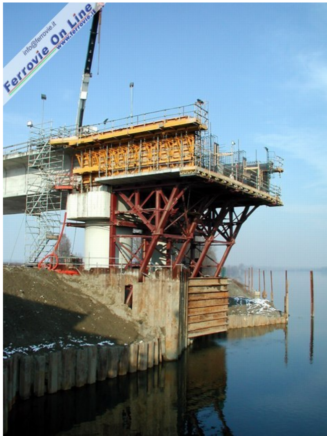
La pila sulla sponda destra con la cassaforma dell'ultimo concio dell'impalcato. (Foto Pietro de' Castiglioni, novembre 2005)
