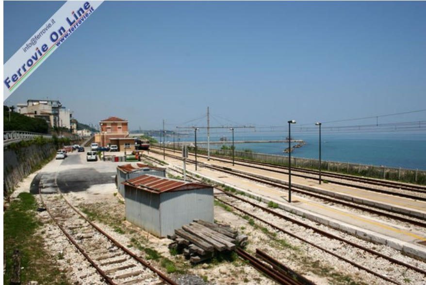
Panoramica della stazione di San Vito; in primo piano lo scalo merci in disuso. (Foto David Campione, 25 giugno 2005)
