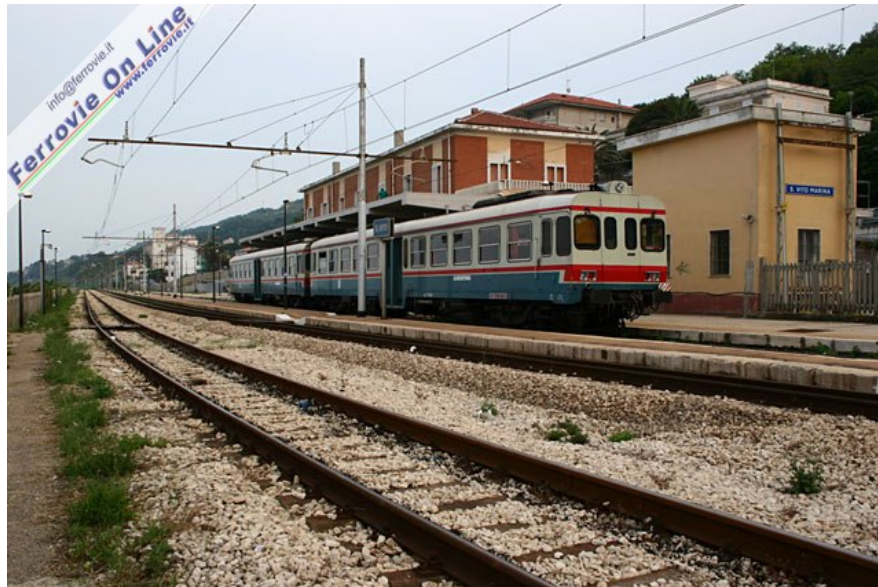
Vista d'insieme per la piccola stazione di San Vito Lanciano. In sosta sul primo binario una coppia di automotrici ALn 776 della Sangritana, in attesa di partire per Lanciano. (Foto David Campione, 25 giugno 2005)
