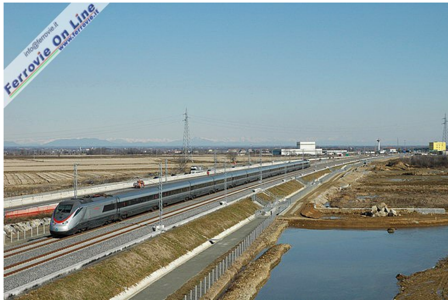
6. Un ETR.500-AV sfreccia sulla linea ad Alta Velocità Torino - Novara, diretto verso Milano, mentre alle spalle il traffico scorre regolare sulla autostrada A4. Foto TTrainsphoto.it , 11 febbraio 2006)
