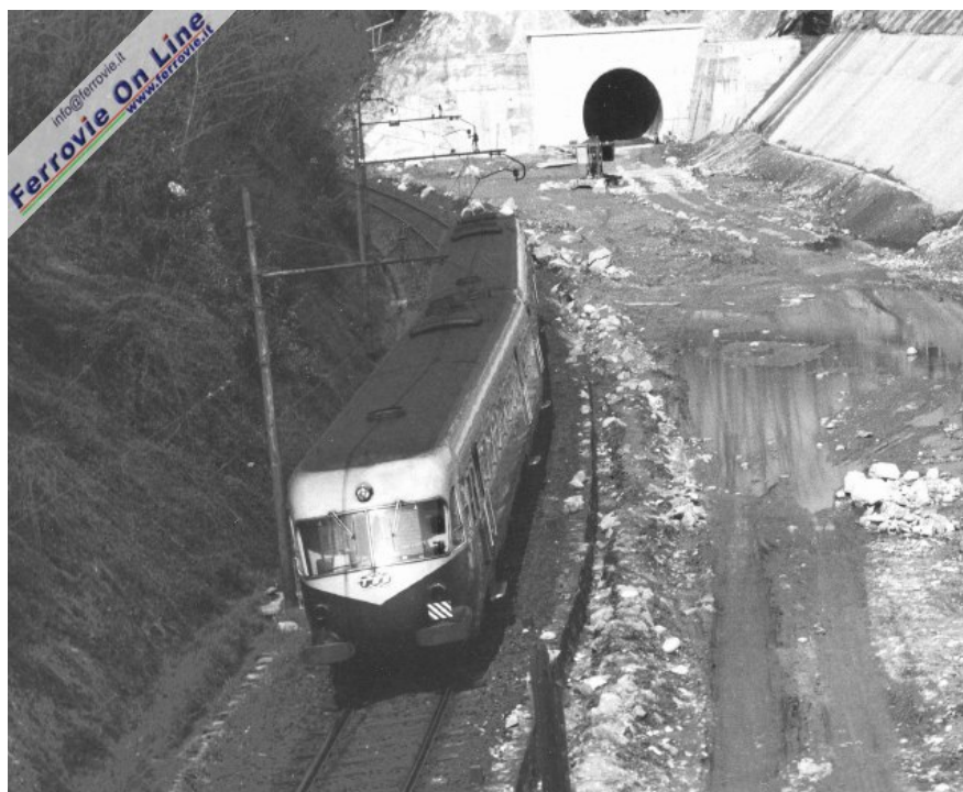
1. Un convoglio di ALn 442/448 nei primi tempi d'esercizio si allontana verso la sua destinazione fiancheggiando un cantiere per lavori di rettifica del tracciato. In primo piano la automotrice con il comparto cucina. (Foto FS)
