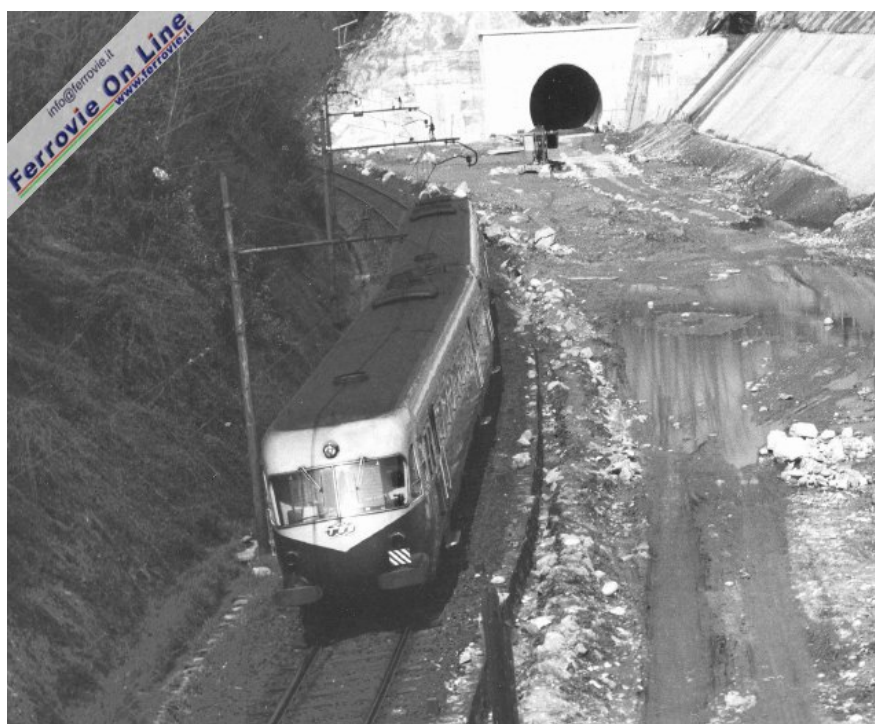
1. Un convoglio di ALn 442/448 nei primi tempi d'esercizio si allontana verso la sua destinazione fiancheggiando un cantiere per lavori di rettifica del tracciato. In primo piano l'automotrice con il comparto cucina. (Foto FS)
