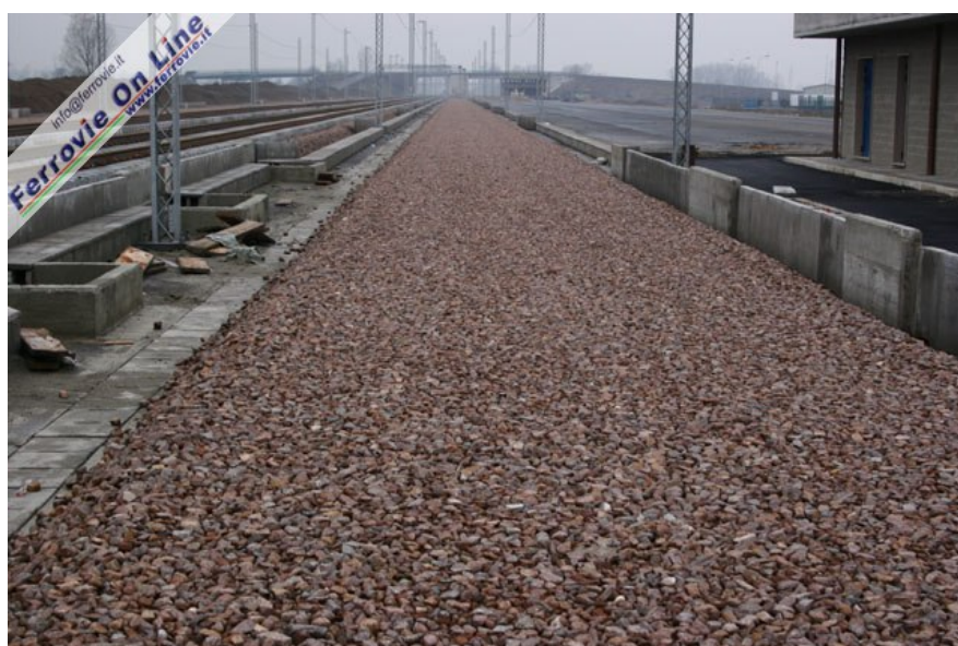
5. Binario di precedenza lato fabbricato di servizio. Qui è stato posato il primo strato di pietrisco, in attesa di poggiare traverse e rotaie. (Foto David Campione, 19 febbraio 2006)
