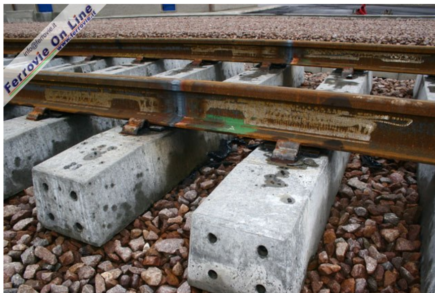
4. Particolare del binario di corsa dispari. Le rotaie sono già quelle definitive UIC 60, prodotte in barre da 108 metri lineari, qui in corrispondenza del punto di saldatura. Le traverse su cui poggiano sono anch'esse definitive, corrispondenti al modello RN specifico per l'Alta Velocità. Alla data della foto mancano gli attacchi Pandrol tra rotaia e traversa. (Foto David Campione, 19 febbraio 2006)
