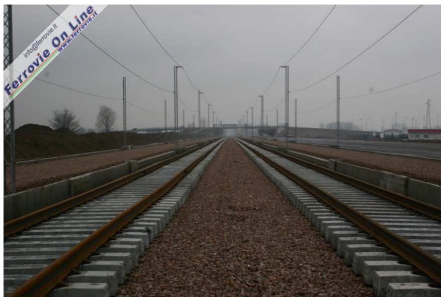
3. I binari di corsa poggiati sul primo strato di massicciata nel P.M. di Casalpusterlengo, visti verso Milano. (Foto David Campione, 19 febbraio 2006)
