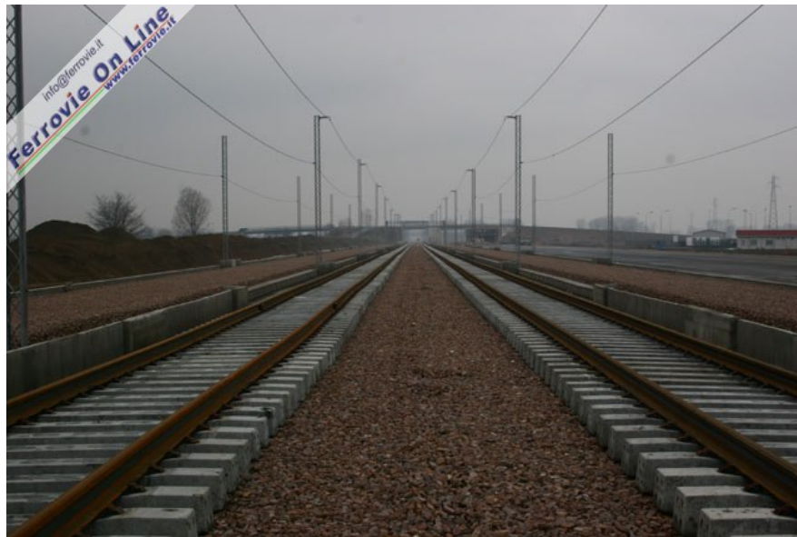
3. I binari di corsa poggianti sul primo strato di massiciata nel P.M. di Casalpuusterlengo, visti verso Milano. Foto David Campione, 19 febbraio 2006
