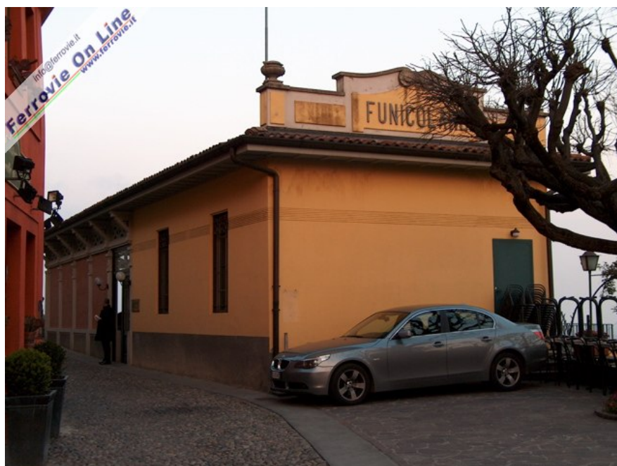
Un'altra vista esterna della stazione superiore che mantiene lo stile architettonico originario. Foto Mario De Prisco, 14 aprile 2005
