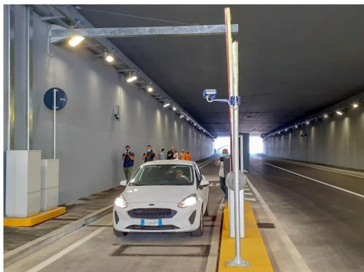
Le due nuove corsie sono attrezzate con un impianto di controllo degli accessi per il ritiro del ticket che attiva l'apertura della sbarra di ingresso, dove è anche presente un sistema di rilevamento delle targhe per l'apertura automatica a taxi e ncc registrati, telecamere di sorveglianza e pannelli segnaletici con informazioni in tempo reale sulla disponibilità di posti auto liberi nei tre parcheggi di stazione.
