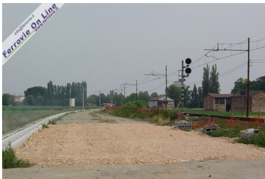
7. Decisamente più arretrati i lavori di raddoppio tra S. Felice sul Panaro e Mirandola. Le opere civili sono appena abbozzate, ma la futura sede ferroviaria risulta già predisposta, ad eccezione dei tratti in corrispondenza dei passaggi a livello. Nell'immagine, la situazione dei lavori in corrispondenza del segnale di avviso di S. Felice sul Panaro. Pressoché inesistenti, invece, i cantieri nel tratto Mirandola - Poggio Rusco. (Foto Fabio Veronesi, 17 giugno 2006)
