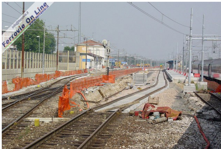
9. Tra Roncanova di Gazzo Veronese e Nogara la ferrovia viaggia già su nuova sede, anche se ancora a semplice binario. In stazione a Nogara è in corso il rifacimento del piazzale, con realizzazione dei sottopassi. Nell'immagine sono evidenti i lavori in corrispondenza dell'ex binario III. (Foto Fabio Veronesi, 17 giugno 2006)
