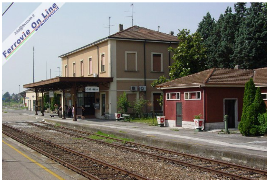
8. Finalmente ben avviata anche la costruzione del ponte sul fiume Po, tra Revere e Ostiglia: le pile in alveo sono in fase di completamento. La stazione di Ostiglia, telecomandata punto - punto da Nogarà dall'agosto 2005, sarà dismessa e sostituita da un nuovo impianto posto più ad est costituito da una fermata e da un Posto di Comunicazione. Tra Ostiglia e Roncanova di Gazzo Veronese sono in corso di realizzazione le opere per lo scavalco dell'idrovía Fissero - Tartaro - Canal Bianco e di altri corsi d'acqua minori. (Foto Fabio Veronesi, 17 giugno 2006)
