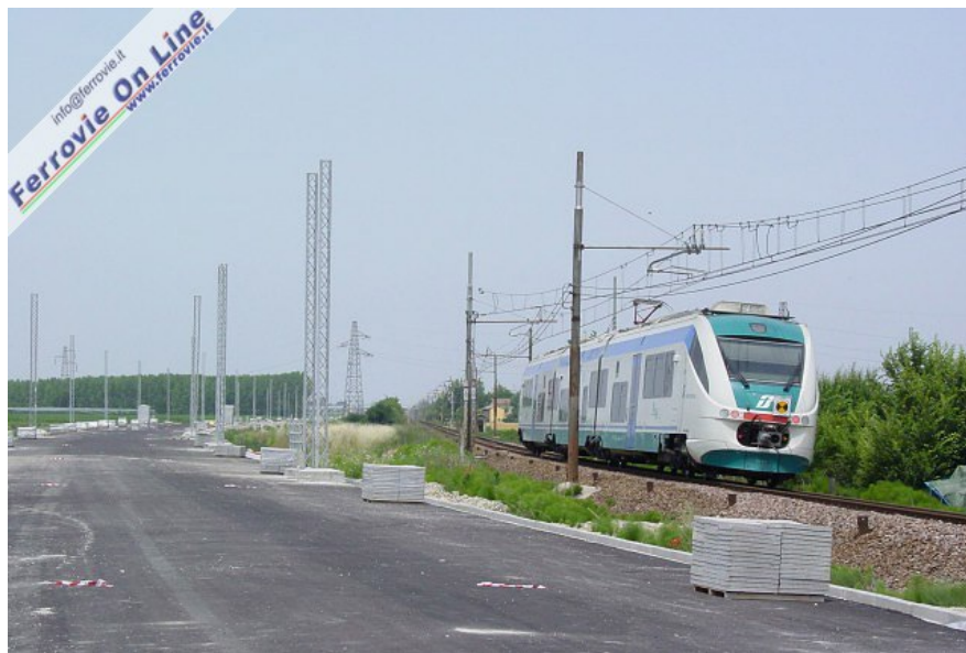
3. La stazione di Crevalcore è interessata da imponenti lavori di modifica del piazzale e attualmente mantiene in esercizio solo i due binari più a est. Con l'attivazione del nuovo doppio binario fino a P.C. Persiceto Nord, entrerà in funzione il nuovo ACEI e il dispositivo di armamento sarà costituito da due binari di corsa lato Bologna, da un unico binario per entrambi i sensi di marcia lato Ostiglia, e da tre binari di precedenza. Nella foto, il Regionale 11454 Bologna C.le - Poggio Rusco ha appena lasciato la stazione di Crevalcore e, dopo aver percorso un breve tratto modificato lo scorso aprile, si dirige verso Camposanto. Sulla sinistra la nuova sede a doppio binario della tratta Crevalcore - S. Felice sul Panaro, già pronta ad accogliere i binari fino a Bolognina. (Foto Fabio Veronesi, 17 giugno 2006)
