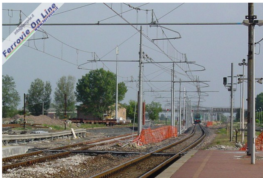
6. L'IR 2266 Bologna C.le - Brennero, qui in arrivo a S. Felice sul Panaro, sta percorrendo la breve variante di tracciato attivata all'inizio di maggio. In fondo a destra è visibile la vecchia sede del binario unico, con il relativo varco creato sotto il nuovo cavalcavia. Attualmente la stazione di S. Felice sul Panaro ha in esercizio soltanto due binari, in quanto il III e il IV sono stati dismessi. (Foto Fabio Veronesi, 17 giugno 2006)
