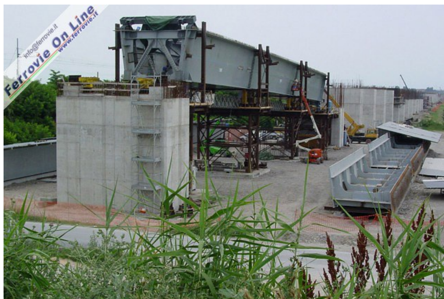
4. L'opera più imponente in corso di realizzazione su questa tratta è senza dubbio il ponte sul fiume Panaro, con le due lunghe rampe di accesso. Una delle travate metalliche che costituiranno il ponte vero e proprio è qui ripresa durante le ultime fasi di assemblaggio fuori opera. Sullo sfondo, la lunga serie di pile in costruzione sul versante bolognese. (Foto Fabio Veronesi, 17 giugno 2006)
