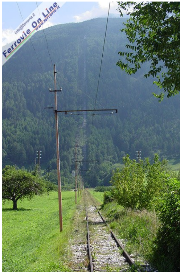
7. Dal passaggio a livello senza barriere posto sul percorso ciclabile si ha questa vista sulla ferrovia industriale della Lasa Marmo. In primo piano la ferrovia inferiore, con la linea aerea in disuso. Sulle pendici della montagna si intuisce la presenza del piano inclinato, con raddoppio centrale. (Foto Fabio Veronesi, 18 agosto 2006)
