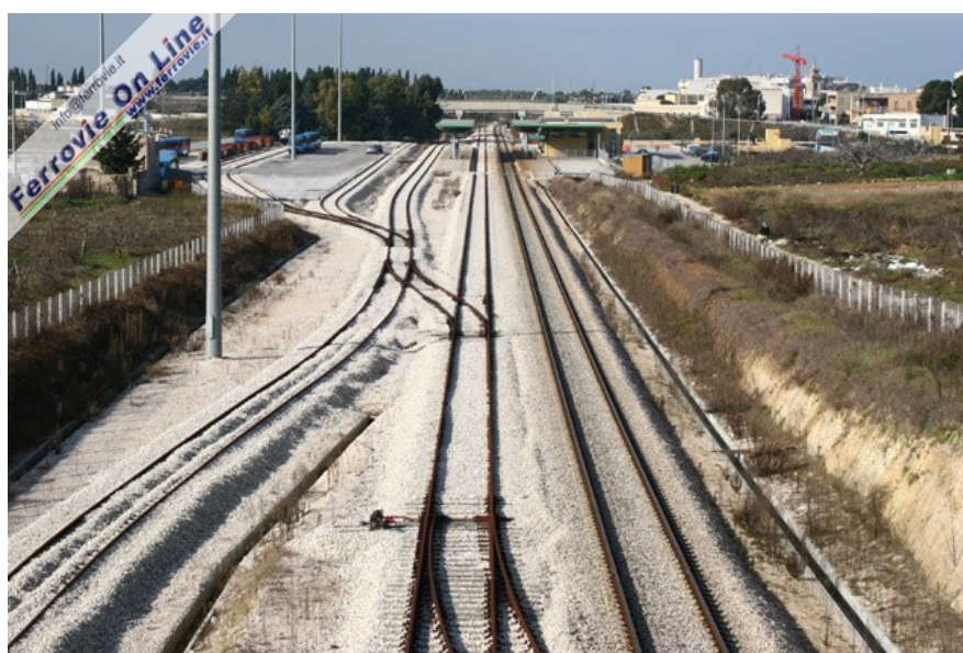
Panoramica del nuovo impianto di Noicattaro, attualmente classificato come fermata seppur presenziato. Il raddoppio che ha origine da qui non è al momento operativo, i deviatori di stazione sono tutti immobilizzati e comunque a comando manuale. L'unico binario in servizio è il dispari, a destra nella foto. A sinistra l'asta di manovra al servizio dell'ampio scalo merci, attualmente adibito al parcheggio di autobus delle FSE in disuso. (Foto David Campione, 27 dicembre 2006)
