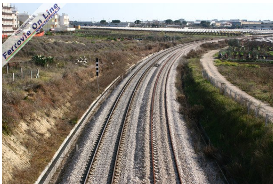
Partiranno a gennaio i lavori per rendere operativo il raddoppio Noicattaro - Rutigliano, con la messa in opera dei segnali e degli impianti ACEI necessari per la circolazione. Nell'immagine l'ampio curvone in uscita da Noicattaro, con a sinistra il binario già in esercizio. Qui termina la breve variante di tracciato: a sinistra si riconosce il sedime su cui correva il semplice binario a servizio della vecchia stazione. (Foto David Campione, 27 dicembre 2006)
