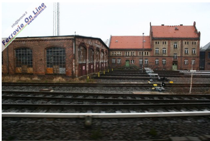
7. La rimessa locomotive di Grunewald, ripresa in corsa verso Wannsee. Foto David Campione, 3 marzo 2007
