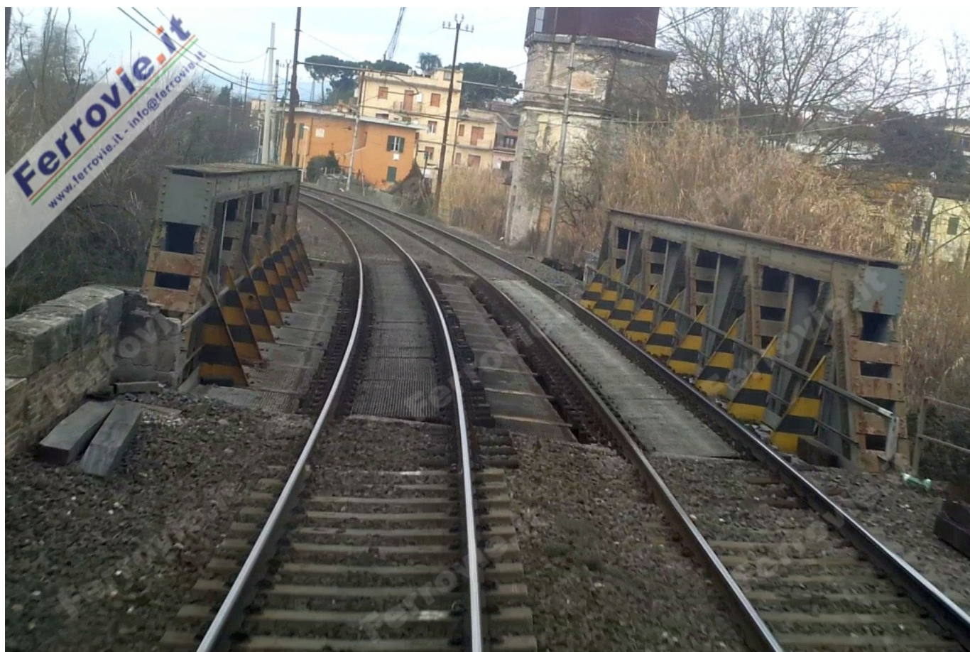
Il ponte in ferro in ingresso a Fara Sabina, lato Settebagni.
