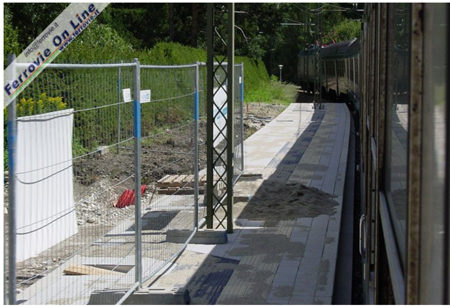
Il marciapiede in costruzione della nuova fermata di San Lorenzo di Sebato visto da un treno in transito. La fermata si trova letteralmente a pochi passi dal centro del paese. Il termine dei lavori è previsto per settembre. (Foto Fabio Veronesi, 9 agosto 2008)
