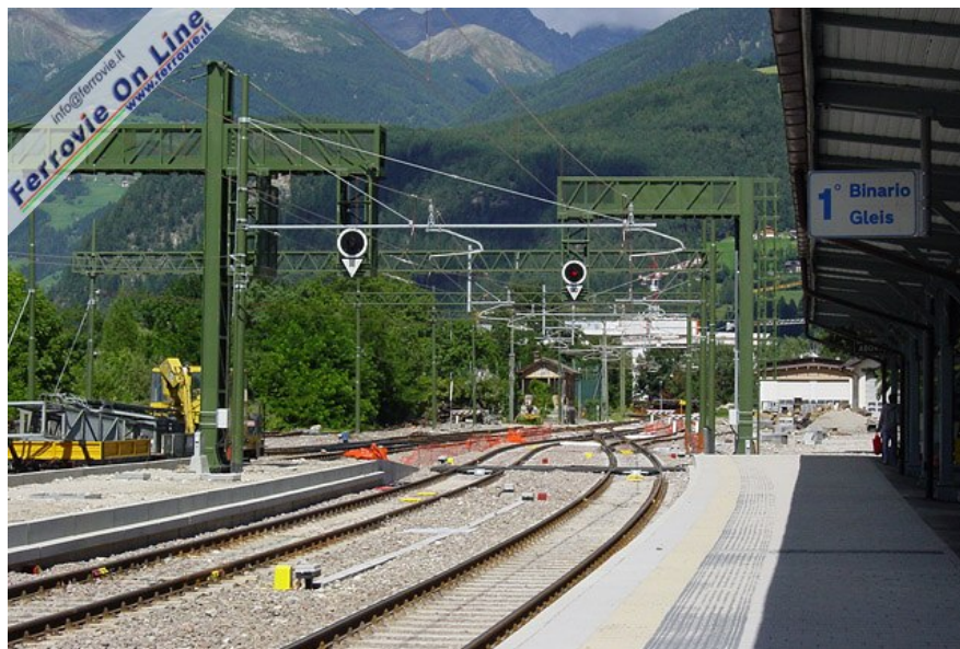
La stazione di Brunico in direzione San Candido. In evidenza il marciapiede rialzato del binario 1 e il marciapiede centrale in fase di ultimazione. A settembre saranno attivati il binario di corretto tracciato e un ulteriore binario di circolazione. (Foto Fabio Veronesi, 9 agosto 2008)
