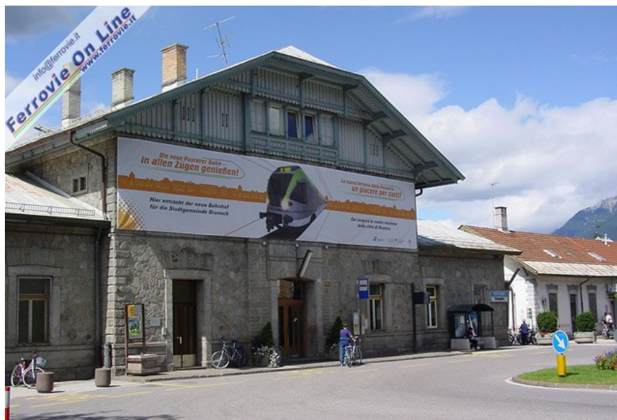
A Brunico, la cittadina più importante di tutta la Pusteria, un grande cartello sulla facciata esterna del fabbricato viaggiatori pubblicizza i lavori di potenziamento in corso. Sul piazzale esterno e sul marciapiede del binario 1 sono presenti ulteriori pannelli informativi. (Foto Fabio Veronesi, 9 agosto 2008)
