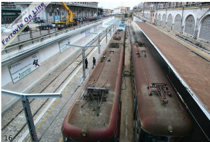
16. Piazzale di stazione di Bari Centrale FT visto dall'alto, dopo le recenti modifiche. Il binario sulla sinistra è stato addossato al muro spostando il marciapiede al centro, per rendere fruibile al servizio viaggiatori anche il binario intermedio. (Foto David Campione, 27 dicembre 2008) 17. Il piazzale visto dal lato opposto, con tre moderni ELT 200 in sosta. E' in fase di completamento la realizzazione della pensilina sul nuovo marciapiede. Sullo sfondo gli uffici della Ferrotramviaria Spa.
