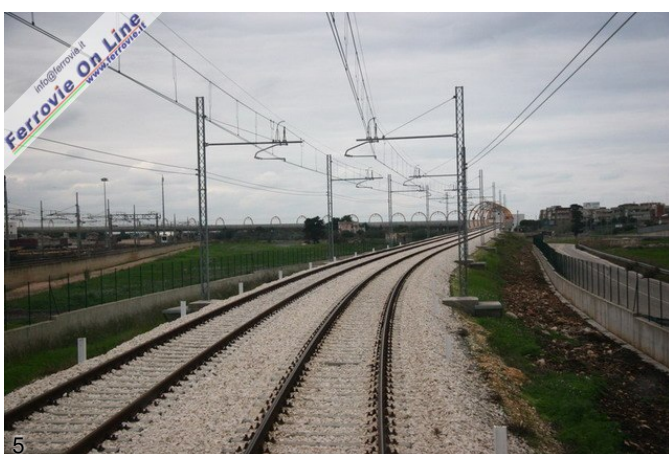
5. Il tratto di 1.100 metri in piano e rilevato, subito dopo la stazione di Fesca-San Girolamo. Sulla sinistra la linea RFI Bari - Foggia, che viene scavalcata dalla linea metropolitana con il viadotto visibile sullo sfondo. A destra sullo sfondo si riconosce il doppio binario della Ferrotramviaria per Barletta. (Foto David Campione, 27 dicembre 2008)
