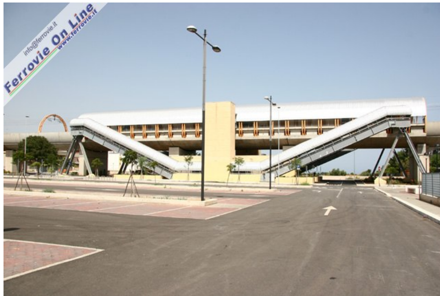
14. La fermata di Tesoro, l'unica del nuovo tracciato allo scoperto, sorge sul viadotto di 2.400 metri. (Foto David Campione, 15 agosto 2008)
