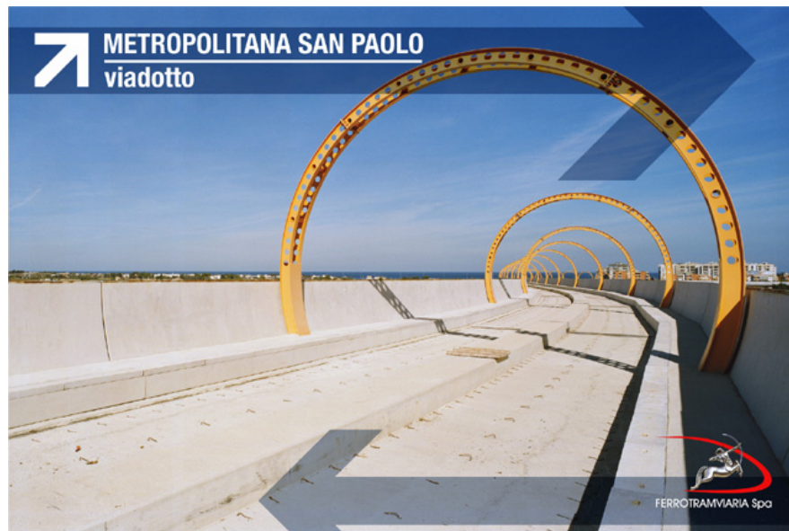
12. Viadotto in fase di costruzione, con la sede pronta per ricevere le piastre in cemento armato. Foto Ferrotramviaria
