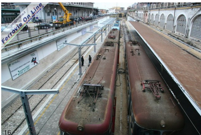
16. Piazzale di stazione di Bari Centrale FT visto dall'alto, dopo le recenti modifiche. Il binario sulla sinistra è stato addossato al muro spostando il marciapiede al centro, per rendere fruibile al servizio viaggiatori anche il binario intermedio. (Foto David Campione, 27 dicembre 2008)
