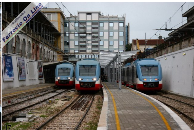
16. Piazzale di stazione di Bari Centrale FT visto dall'alto, dopo le recenti modifiche. Il binario sulla sinistra è stato addossato al muro spostando il marciapiede al centro, per rendere fruibile al servizio viaggiatori anche il binario intermedio. (Foto David Campione, 27 dicembre 2008)
