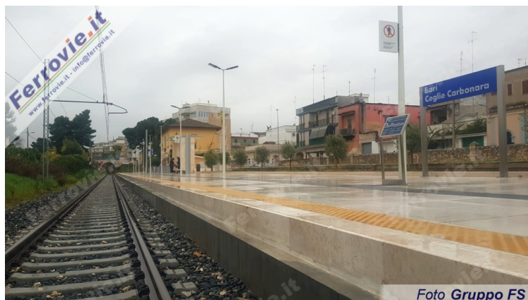
4. Marciapiede innalzato per incarrozzamento a raso, nella fermata di Bari Ceglie Carbonara. (Foto Gruppo FS)
