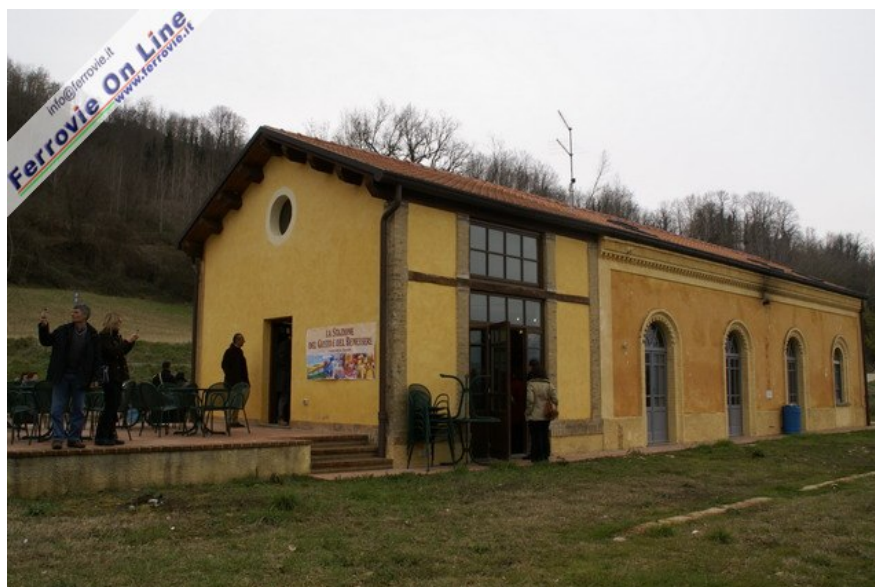
La sezione di Fermo di Italia Nostra ha organizzato delle escursioni sulla linea Porto San Giorgio-Fermo-Amandola, chiusa nel 1956. Le immagini sono relative alla ex stazione di Montefalcone, oggi di Smerillo. Il recupero del fabbricato, adibito a emporio di prodotti tipici, è stato progettato dall'architetto Giuliano Coltrinari. (Foto Gioacchino Fasino - Italia Nostra )
