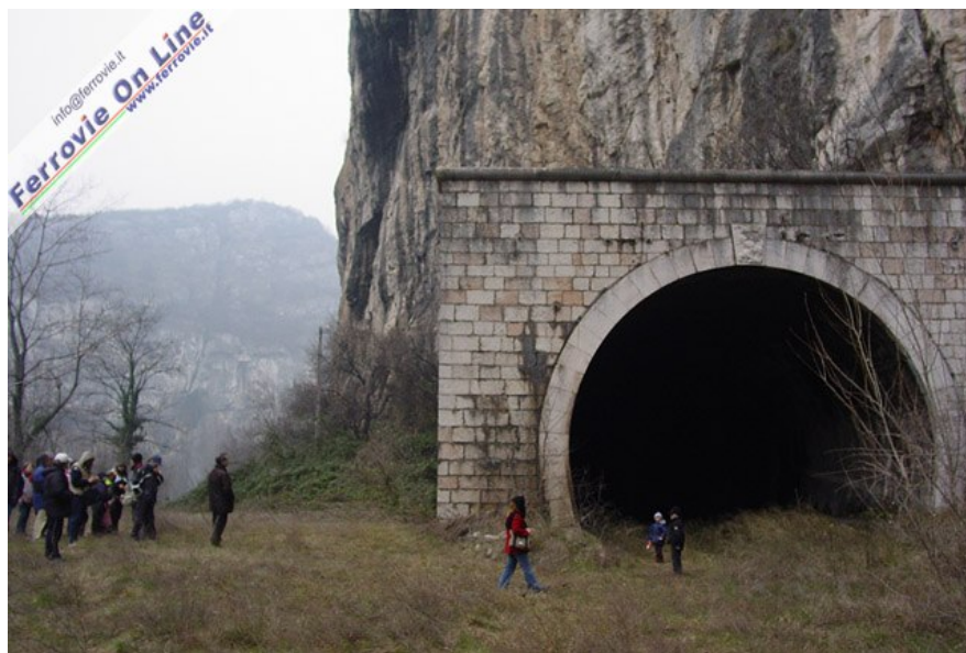
L'imbocco sud della vecchia galleria posta sul celebre tratto noto come la Chiesa di Ceraino, abbandonato in seguito all'attivazione della nuova variante quasi completamente in galleria (novembre 1998). Probabilmente il vecchio tracciato verrà recuperato per la realizzazione di una ciclabile che sarà parte integrante della Ciclopista del Sole. (Foto Fabio Veronesi, 1 marzo 2009)
