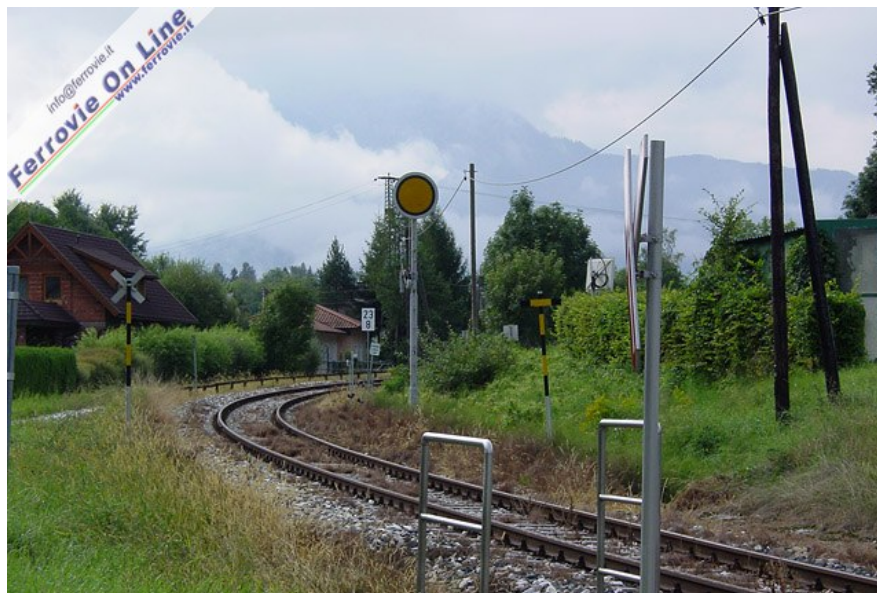
14. Da Viktring a Feistritz si costeggia in alcuni tratti la ferrovia Klagenfurt - Rosenbach, che in quest'ultima località si innesta nella linea, proveniente da Villach, che raggiunge Jesenice (SLO) attraverso il tunnel delle Caravanche. Si tratta di un museo a cielo aperto, con segnali ancora comandati a fune e che prevede da orario la circolazione di soli tre treni viaggiatori nei giorni feriali, escluso il periodo estivo. Nell'immagine un segnale di avviso a disco girevole tra Viktring e Maria Rain. (Foto Fabio Veronesi, 21 agosto 2008)
