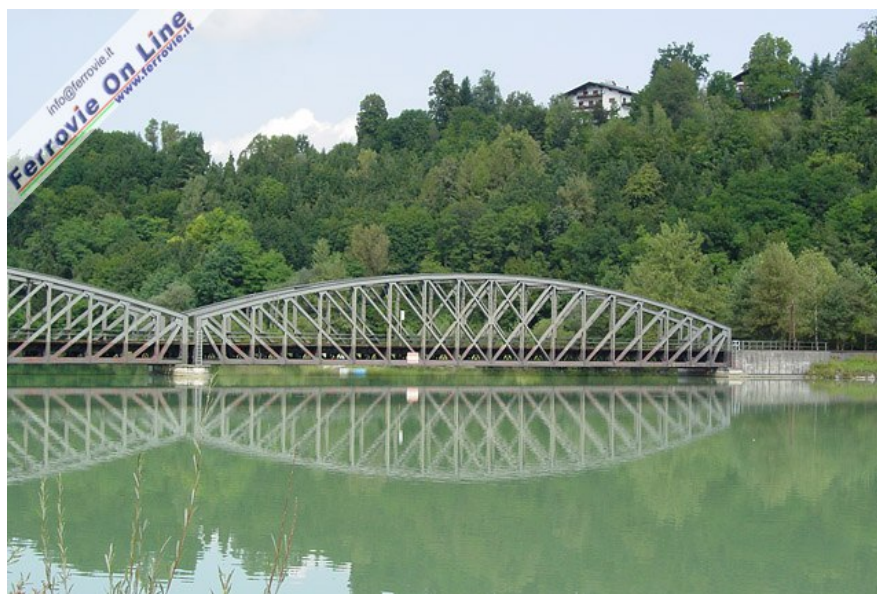
15. Un caratteristico ponte in ferro permette alla ferrovia Klagenfurt - Rosenbach di superare la Drava, che ormai ha raggiunto dimensioni di tutto rispetto. (Foto Fabio Veronesi, 21 agosto 2008)
