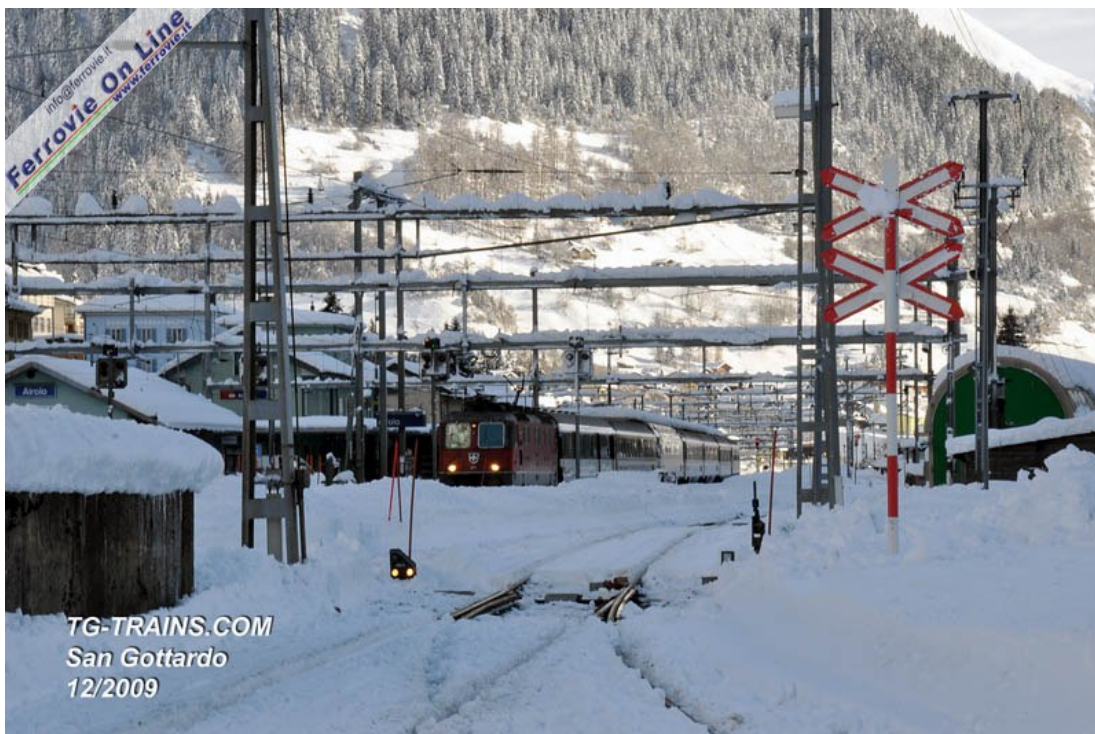
Nella stazione di Airolo, l'ultima in Ticino prima del tunnel del Gottardo, un IR sta per imboccare il traforo Foto Tg-Trains.com, 2 dicembre 2009
