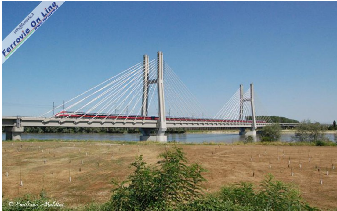
Piacenza - Sulla linea AV/AC Milano - Bologna, un ETR.500 FRECCIAROSSA transita sul ponte strallato sul Po, nei pressi di Piacenza, diretto a Roma Termini. Foto Emiliano Maldini, Luglio 2009)
