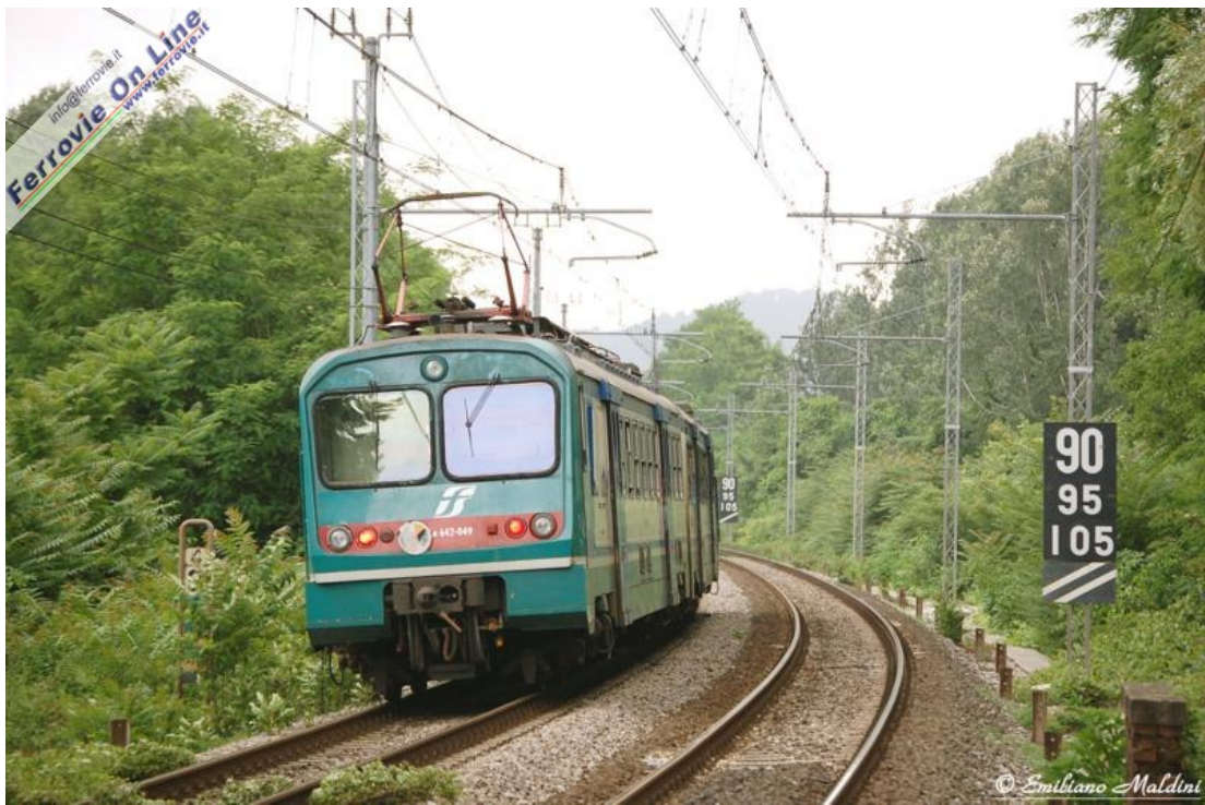
Montuolo (LU) - Tra Lucca e Montuolo le due linee per Viareggio e Pisa corrono affiancate, creando così un "falso" doppio binario, utilizzato in modo promiscuo per i treni da e per Lucca fino alla ex-stazione di Montuolo, oggi soppressa e sostituita da un posto di servizio denominato "Doppio Bivio Montuolo". In questa località è ripreso un treno Regionale da Pisa Centrale per Lucca, spinto dalla ALe 642.049. Giugno 2009. (Foto Emiliano Maldini, giugno 2009)
