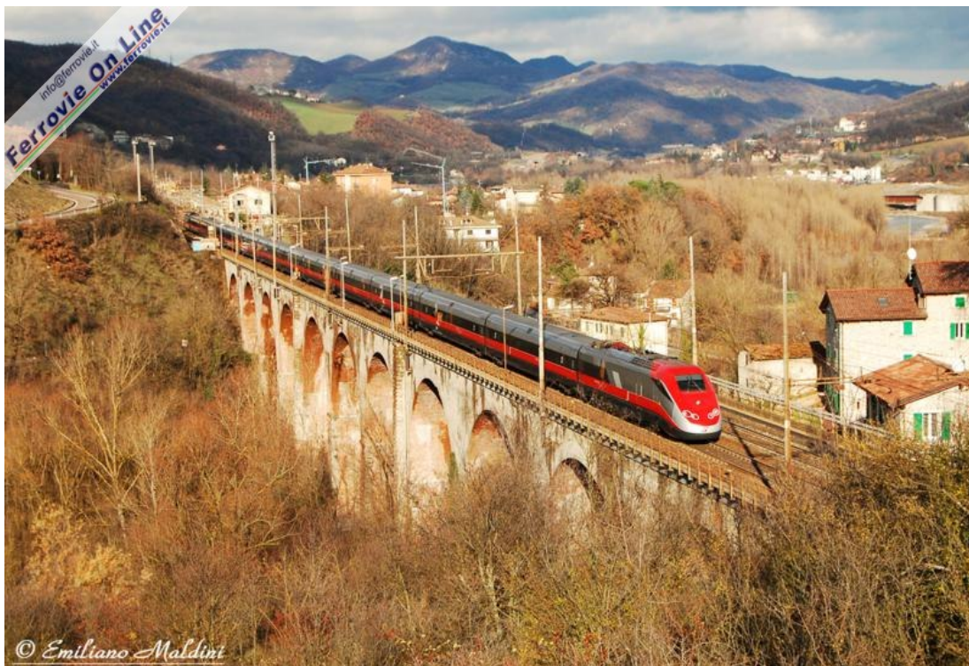
Grizzana Morandi (BO) - Un ETR.500 FRECCIAROSSA, diretto a Roma Termini, transita sul noto viadotto di Grizzana Morandi il 5 Dicembre 2009. A partire dalla settimana successiva tutti gli ES* in servizio tra Bologna e Firenze percorreranno la nuova linea AV/AC, abbandonando così la linea storica via Prato. (Foto Emiliano Maldini, 5 dicembre 2009)
