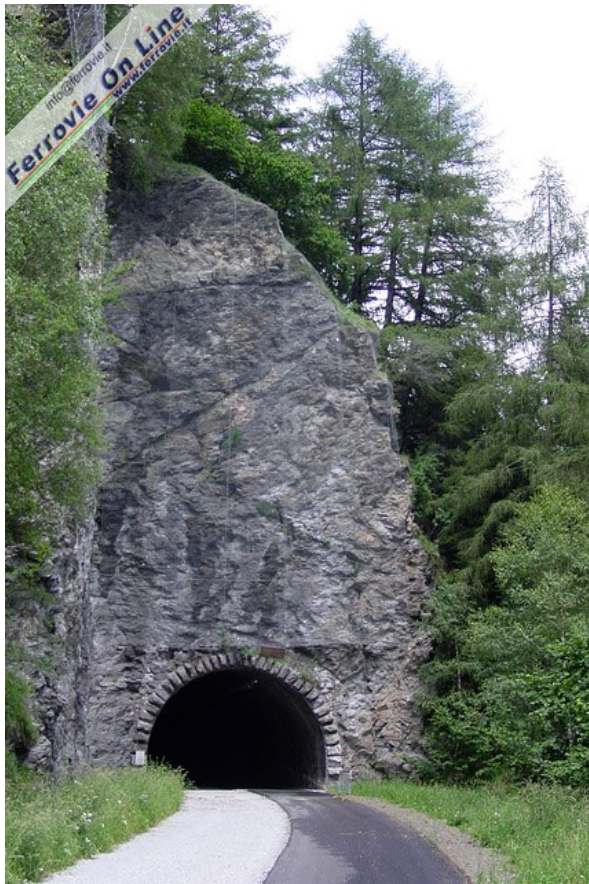
6. La galleria Ponticolo è la seconda e ultima che si incontra viaggiando verso Moncucco. E' sovrastata da un'estesa parete rocciosa a strapiombo sulla pista ciclabile che ha reso anche qui necessaria la copertura con reti di trattenuta per massi e frammenti di roccia. Rispetto all'immagine, attualmente la ciclabile è dotata di segnaletica verticale e orizzontale. (Foto Fabio Veronesi, 11 luglio 2010) 7. Anche la vegetazione non è cambiata di molto, come si può notare in questo raffronto con il 1997. La 1822.003-8 viaggia con il suo treno, erede dei celebri korridorzüge, verso il Tirolo dell'Est. (Foto Franco Pepe, 13 agosto 1997)
