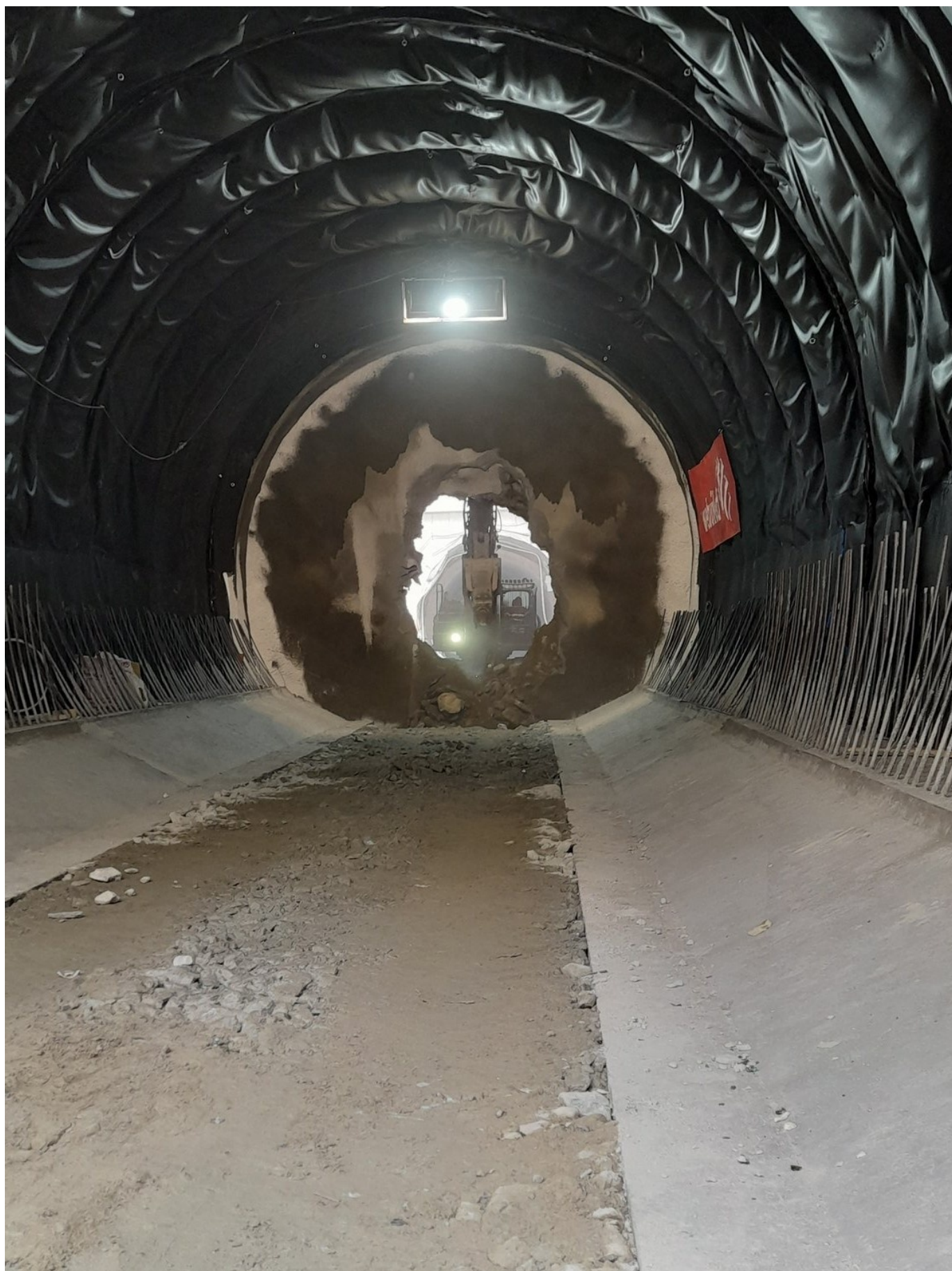
22 Abbattimento dell'ultimo diaframma sotto l'Isarco (Foto BBT)
