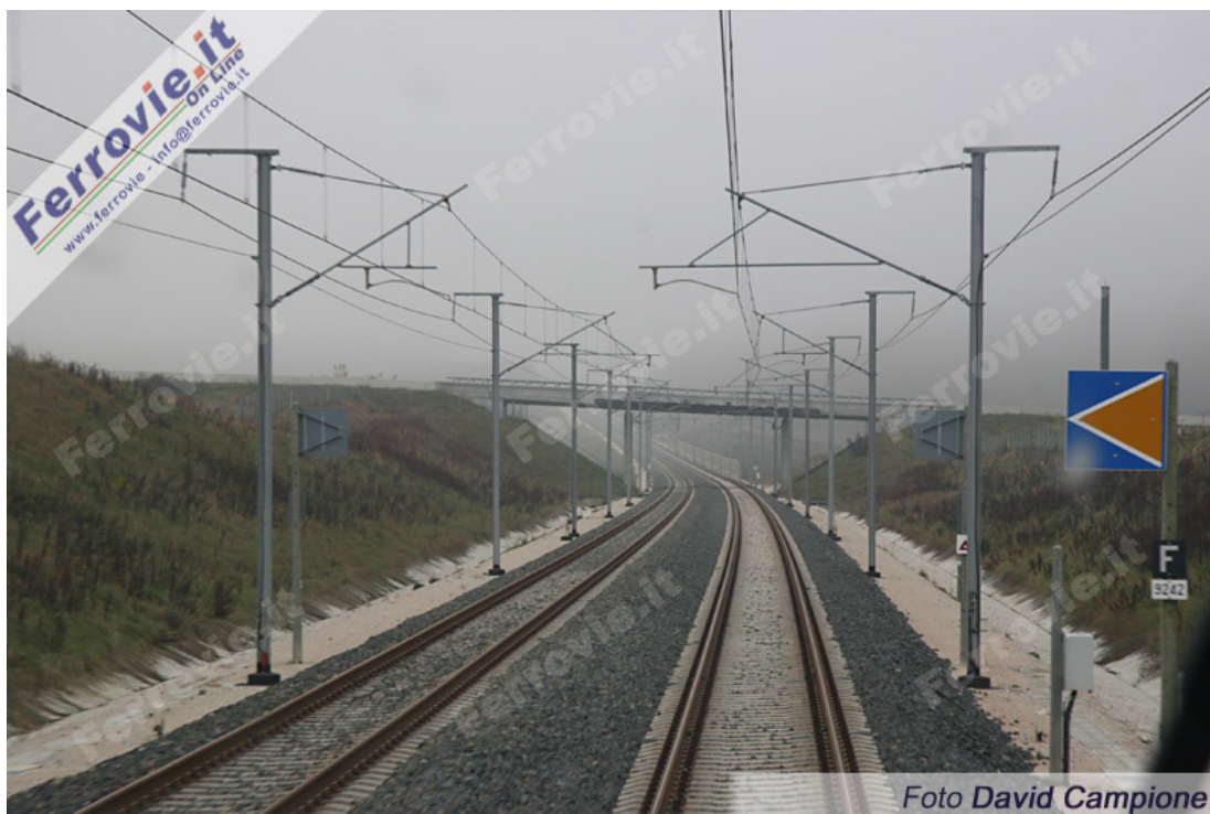
6. In corsa tra Belfort e Besançon. Il segnale blu e giallo a destra indica il passaggio tra due sezioni di blocco contigue. (Foto David Campione, 10 novembre 2011)
