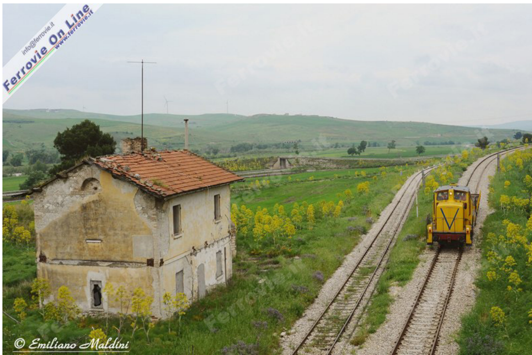
Nel mese di aprile e maggio 2011, a causa di una frana, la linea Foggia - Potenza è stata interrotta tra le stazioni di Rocchetta S. Antonio e Leonessa, per permettere l'esecuzione di lavori di risanamento del tratto in questione alcuni treni cantiere facevano la spola tra le due località. In fotografia vediamo una locomotiva Diesel V 60 ex DB con un carro pianale, in arrivo a Rocchetta S. Antonio. (Foto Emiliano Maldini, 28 aprile 2011)
