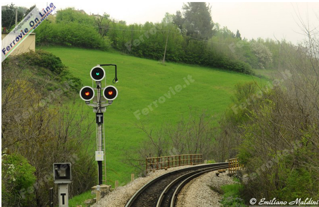
Il tratto di linea tra Avigliano Lucania e Potenza Macchia Romana ha la particolarità di essere in comune tra le linee RFI e FAL ed è armato con tre rotaie e quindi doppio scartamento (950 mm e 1435 mm). In fotografia vediamo uno scorcio di questo tratto, in prossimità del segnale di protezione del posto di movimento Tiera. (Foto Emiliano Maldini, 27 aprile 2011)
