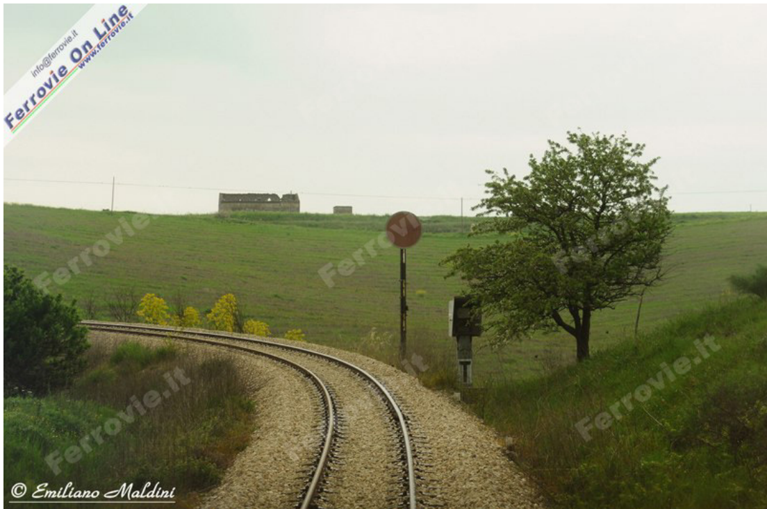
Il segnale di protezione di Irsina, a disco girevole, è uno dei tanti ancora presenti sulla linea Gravina - Potenza. Foto Emiliano Maldini, 27 aprile 2011)
