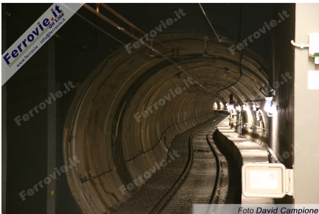
3, La tortuosità del tracciato della B1 risalta in questa immagine nei pressi di Libia, dove il binario segue un andamento curvilineo per inserirsi nel sottosuolo romano. Foto David Campione, 13 giugno 2012
