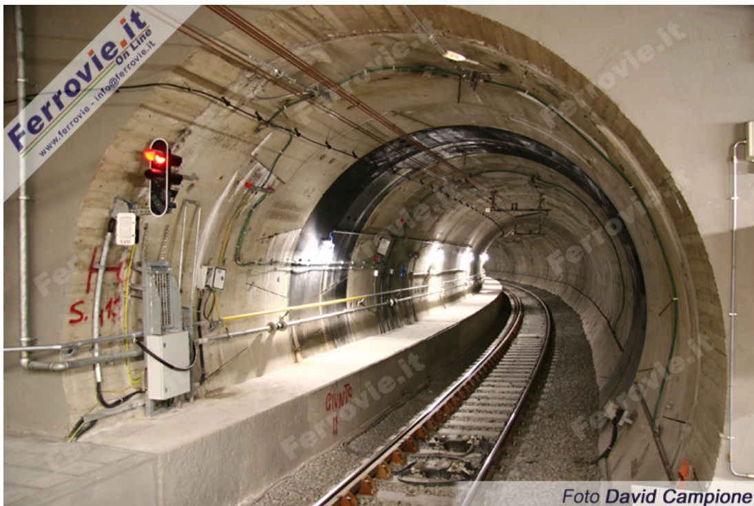
2, Da Bologna a Conca d'Oro i binari corrono in due gallerie indipendenti, a tratti sovrapposte. Qui nei pressi di Annibaliano, con il binario in curva verso Bologna. Foto David Campione, 13 giugno 2012
