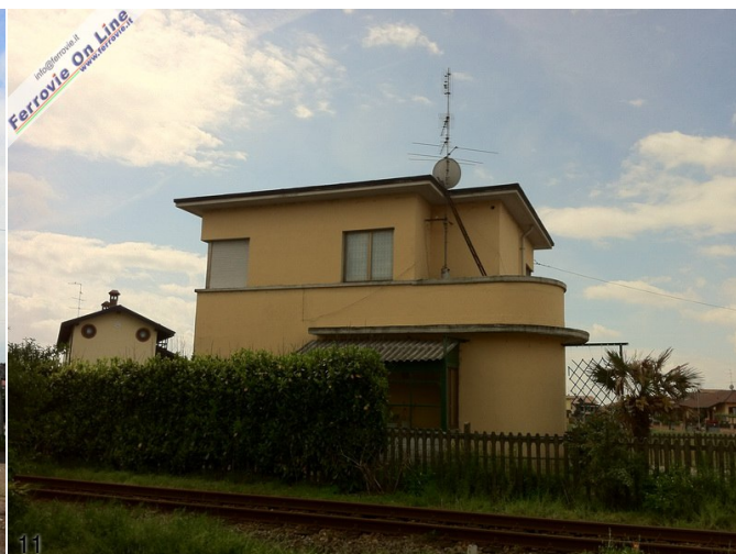
10. Fabbricato viaggiatori della stazione di Nibbia: nonostante il degrado si può notare come esso sia caratterizzato da una combinazione di solidi geometrici semplici. A differenza del fabbricato viaggiatori tipo, questo edificio è maggiormente movimentato e non presenta una simmetria. (Foto Gino Pepe, 5 maggio 2012)
