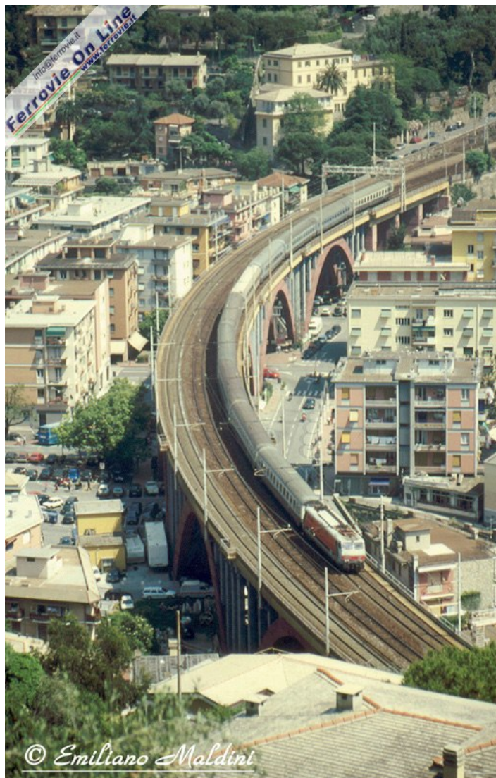
Un treno Intercity per Torino, in transito sul celebre viadotto di Recco, con una E.444. Oggi, purtroppo, questo viadotto è stato dotato di tralicci a portale in luogo dei pali singoli della foto, per cui risulta impossibile ripetere un'inquadratura simile... (Foto Emiliano Maldini, giugno 1999)
