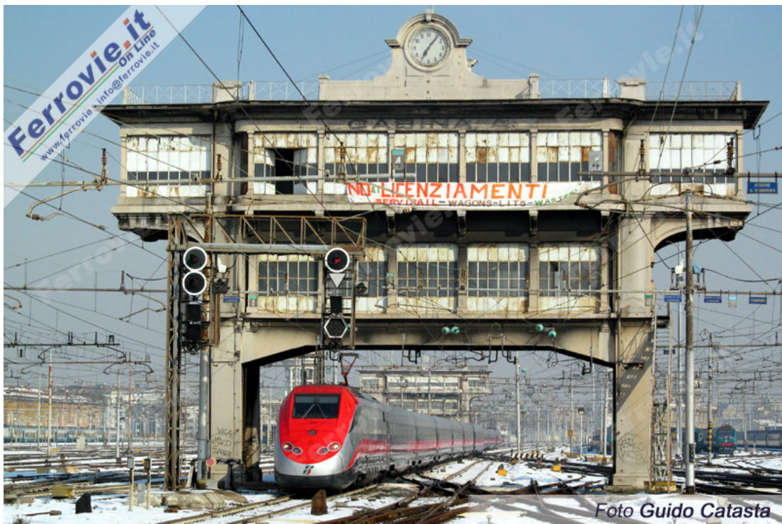
Un ETR.500 in arrivo a Milano Centrale transita sotto la storica cabina, sulla quale campeggia uno striscione esposto dai lavoratori dei vagoni letto, contro i licenziamenti. (Foto Guido Catasta, 9 febbraio 2012)
