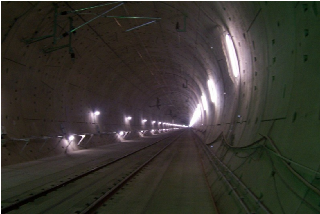
2. L'interno di una delle due canne del Katzenbergtunnel. Si può notare come il piano del ferro sia quasi a raso per permettere il passaggio dei mezzi di soccorso (Foto Wikipedia)
