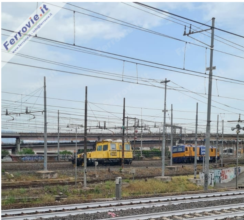
Carrelli di RFI a Roma Termini sulla linea che conduce a Roma Prenestina.
