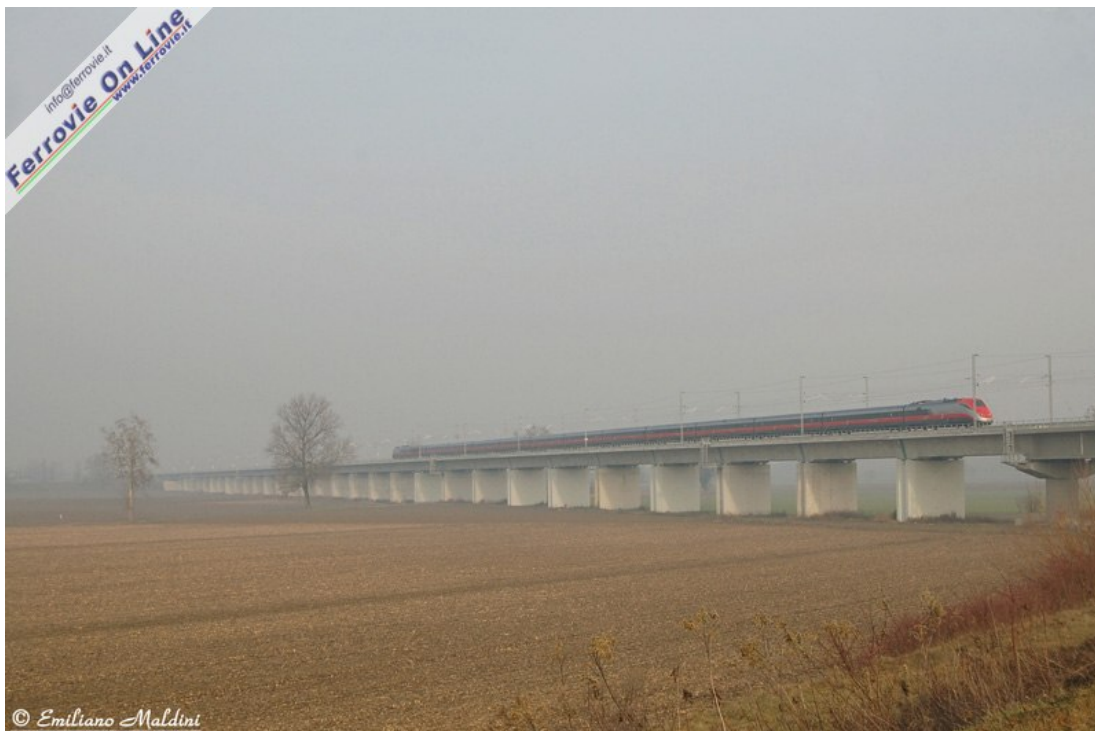
Un ETR 500 in livrea FRECCIAROSSA, transita a 300 Km/h sulla lunga rampa che conduce al ponte strallato sul PO, nei pressi di Piacenza, in una fredda e grigia mattina del dicembre 2008. (Foto Emiliano Maldini, dicembre 2008)
