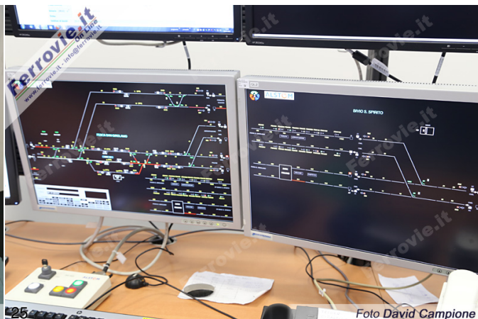
24. Postazione principale dell'Apparato Comando Centrale Multistazione di Alstom per Ferrotramviaria. (Foto David Campione, 16 luglio 2013)
