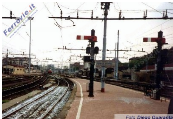
14. La stazione di Torino Porta Nuova che, com'è noto, è stata una delle ultime ad avere abbandonato il segnalamento semaforico di partenza Foto Diego Quaranta, aprile 1992
