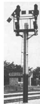
13. Candeliere indicante via libera per l'itinerario di sx, da percorrere a 30 km/h fino a quando il treno non ha superato i deviatoli in uscita
