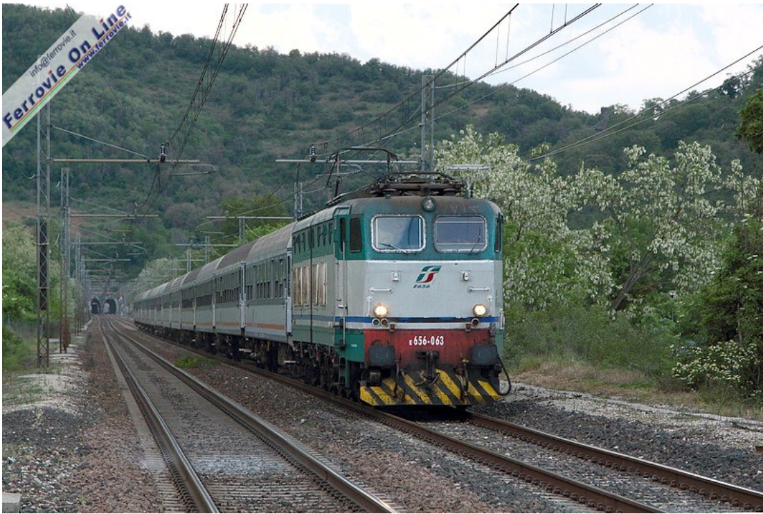
Circa un'ora dopo è il turno del treno 14315, in corsa nei pressi di Battaglia Terme sullo sfondo della galleria del Cataio, l'unica della linea Padova-Bologna. In testa l'E.656.063. (Foto Fabrizio Montignani, 26 aprile 2014)
